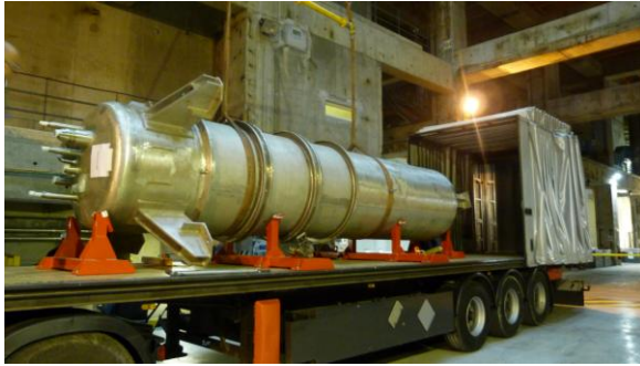
Préparation à l'évacuation vers CentraCo d'un piège à froid après son traitement.
