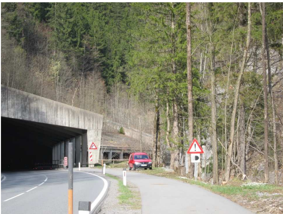
Parkplätze nahe der Ach vor Steinschlaggalerie
