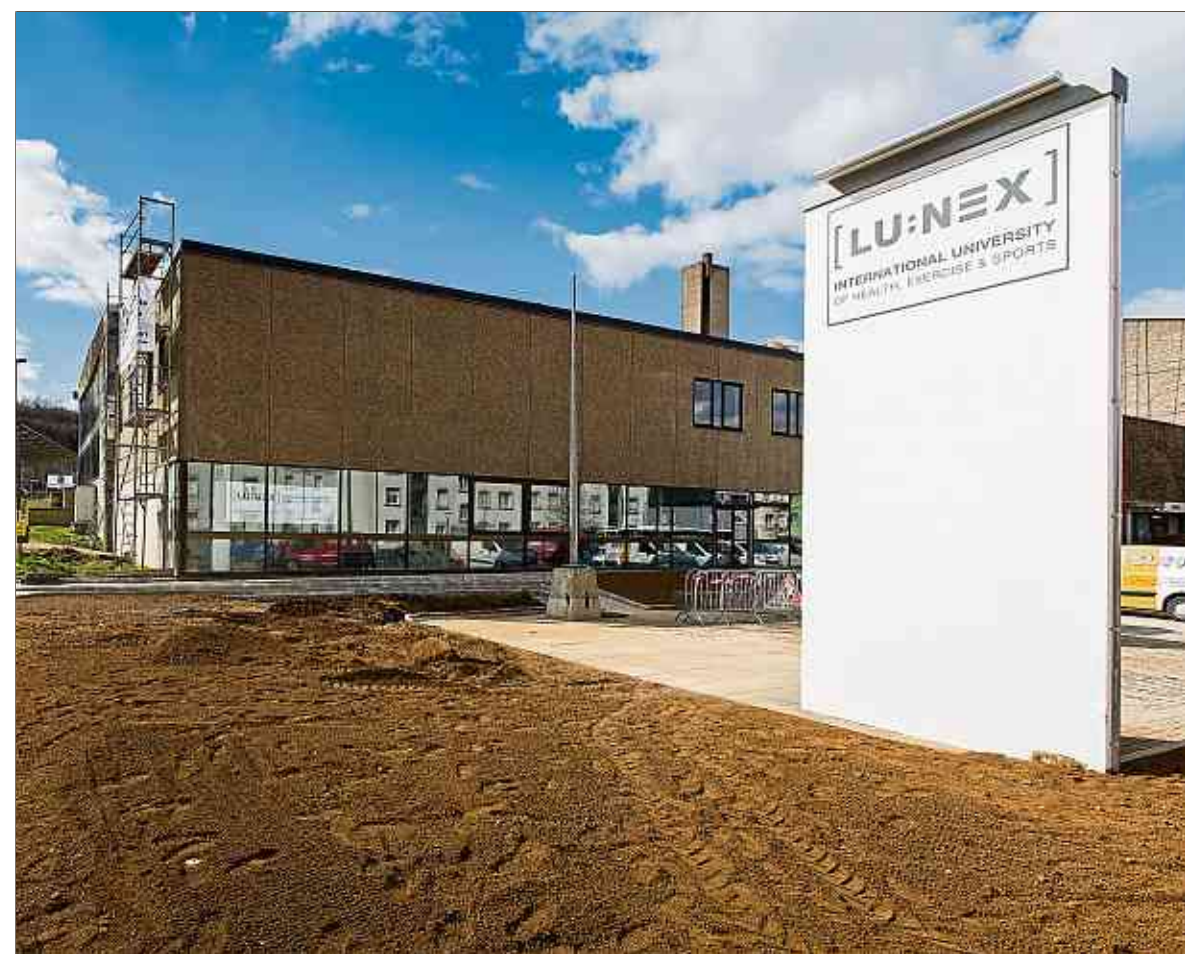
Das Schild steht schon mal, bald werden auch die übrigen Arbeiten abgeschlossen sein.
