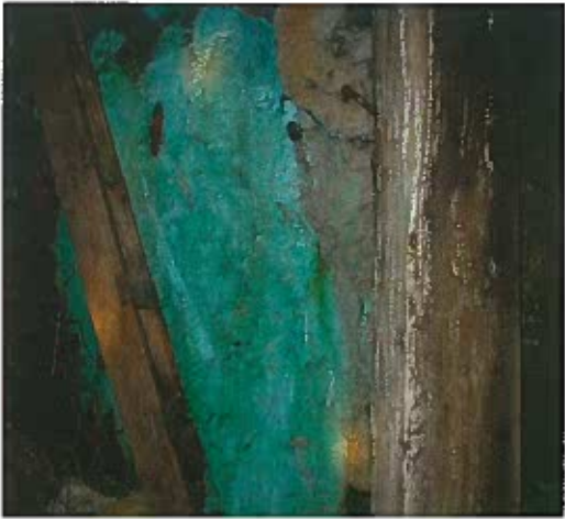
Figuras 4 y 5. Fotos del Drenaje Ácido en una Mina Subterránea.
