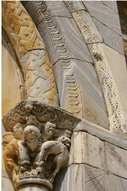
Brouilla (66) - South door
