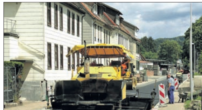
Am 9. Juli 2012 wurde nach mehr als einjähriger Verzögerung der Bauarbeiten endlich die bituminöse Verschleißschicht auf die neu ausgebaute Oderstraße aufgebracht. Foto: Bernd Jackisch
