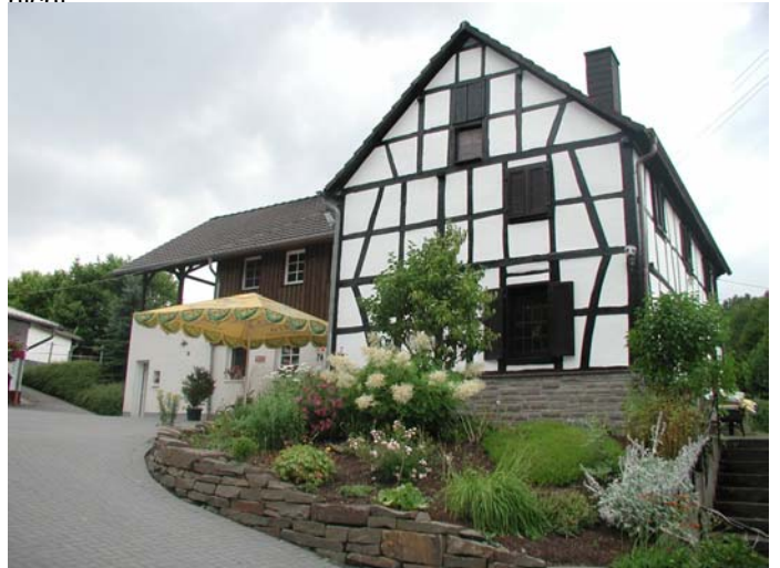
restauriertes Fachwerkhaus mit Anbau in Zeche Aachen
