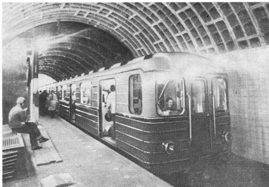
Временное крепление, установленное в путевом тоннеле действующей станции «Технологический институт II» на период реконструкции (удлинения) среднего зала и раскрытия дополнительных проемов
