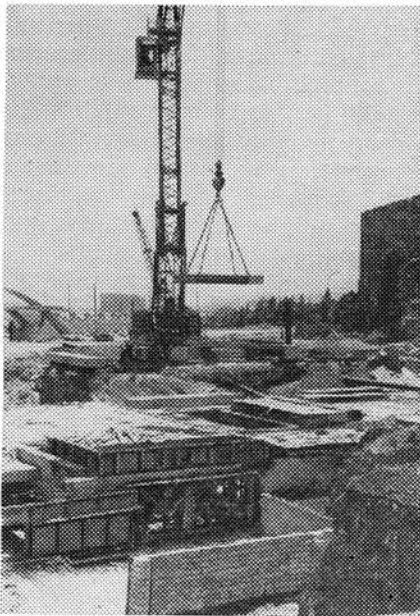
Завершающий монтаж перекрытий вестибюля станции «XI Гызыл орду мейданы».
