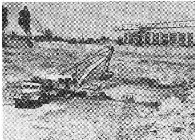
Разработка котлована будущей станции «Иншаатчылар»
