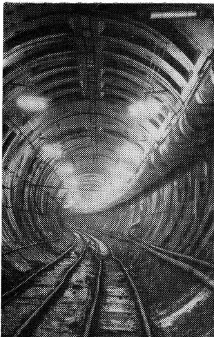
Перегонные тоннели в сборном железобетоне
