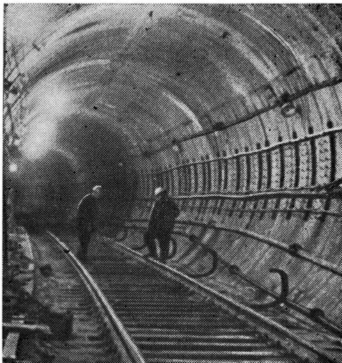
Перегонный тоннель между станциями «Площадь Калинина» и «Почтовая площадь».
