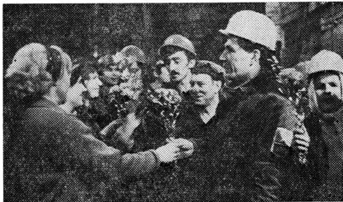
Последняя сбойка по правому перегонному тоннелю «Площадь Калинина» — «Красная площадь». В центре: руководитель свозной бригады Л. Грива.
