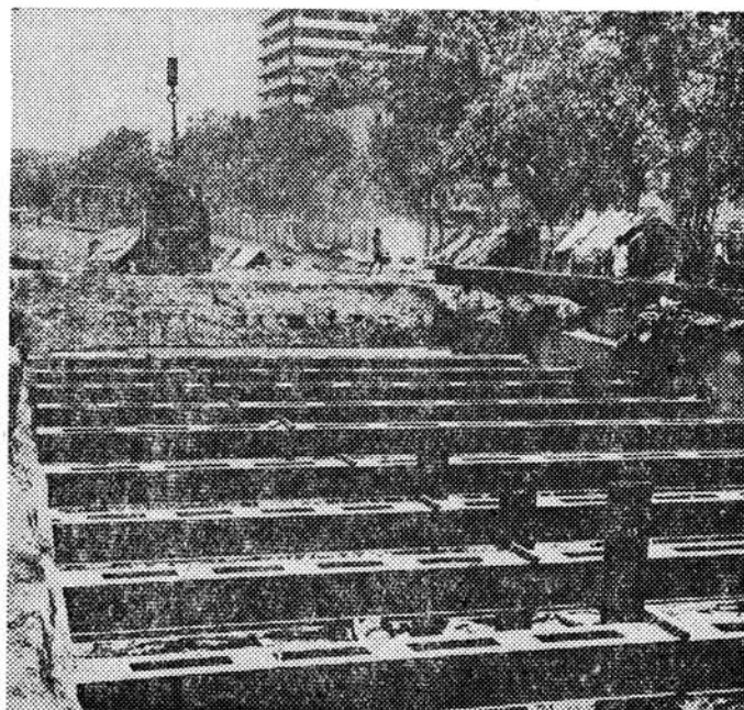
Верхний ярус крепления котлована, используемый для устройства временной проезжей части.
