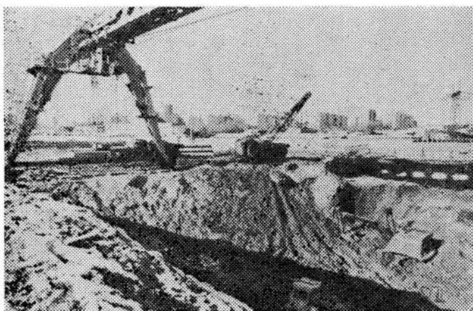
Разработка грунта под северный вестибюль станции «Ботанический сад» (СМУ-9).
