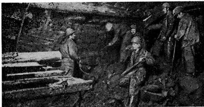
Сбойка на участке тоннеля «ВДНХ» — «Ботанический сад». На снимке: бригада С. Сивца (СМУ-10).
