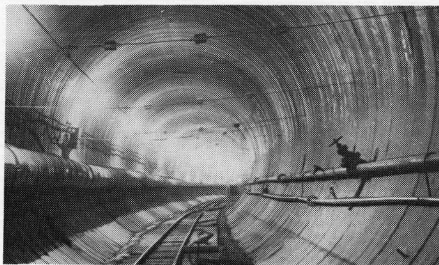
Рис. 5. Перегонный тоннель с монолитно-прессованной бетонной обделкой.
