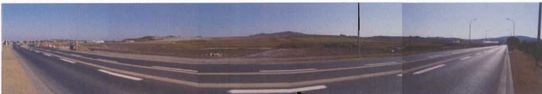
Panoramique sur la zone de Fontanille 2 à partir de la RD 52 / rue Pierre Boulanger. Au 1 er plan, le bassin de rétention en chantier
