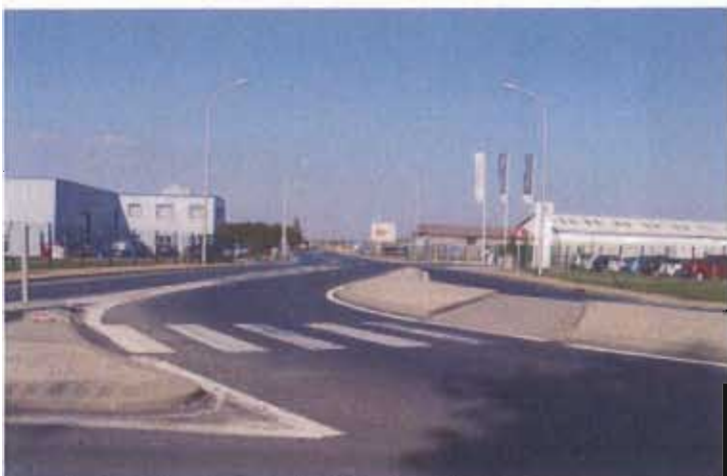
Vue du giratoire au sud de la Fontanille : bureaux, garage et bâtiment agricole présentent des hauteurs de 5 à 6m environ
