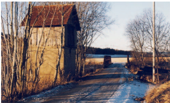
Vanntårnet ved Tønsberg-Eidsfossbanen, med jernbanebrua Foto: Håkon Westby.
