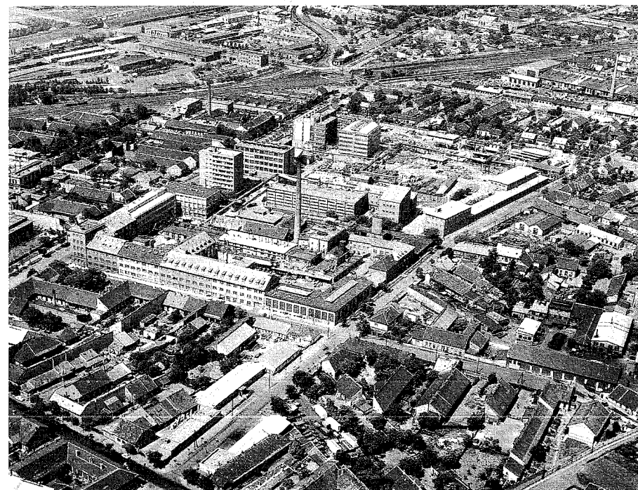
A kőbányai gyártelep a rekonstrukció után (1967)
