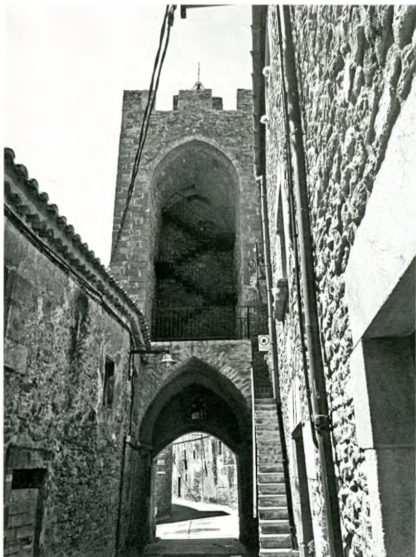
Figura 3: vista de la part posterior de la Torre de les Hores un cop restaurada pel Servei de Monuments. S'hi pot observar la rehabilitació de l'escala de pedra que permet l'accés al primer pis, ja destapiat, i l'escala metàl·lica que permet pujar a la part superior de la torre.
