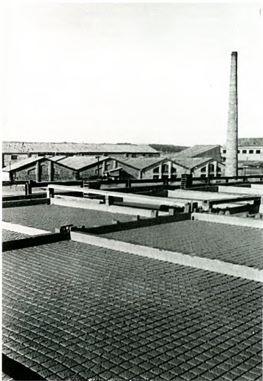
7. Fàbrica Terracota, 1963 ( Manufacturas de Terracota, S.A. ). Basses amb els pans de fang a punt de ser retirats. Autor: fotos Riera (Arxiu d'imatges Terracotta Museu).
