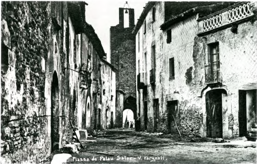
Figura 1: vista posterior de la torre portal de les Hores al primer terç del segle XX. Hi podem observar les restes dels brancals de la porta a la part inferior –desaparegudes a mitjan segle XX–, el tapiat del primer pis i el campanar bastit a la part superior.
