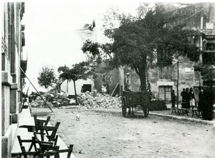
11.- Bombardeig del 22 de gener de 1938 sobre l'edifici de l'Ajuntament i la plaça. (AMSG).
