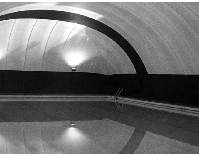
1976 Instal·lació de la coberta de la piscina
