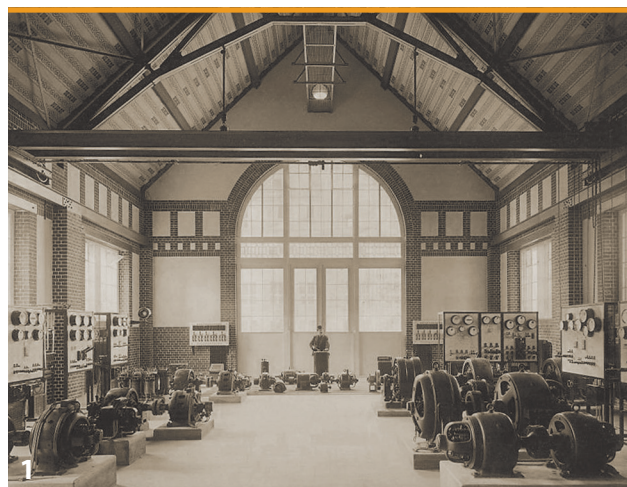
Hala Maszyn Instytutu Elektrotechnicznego przy budynku A-4 [4]
