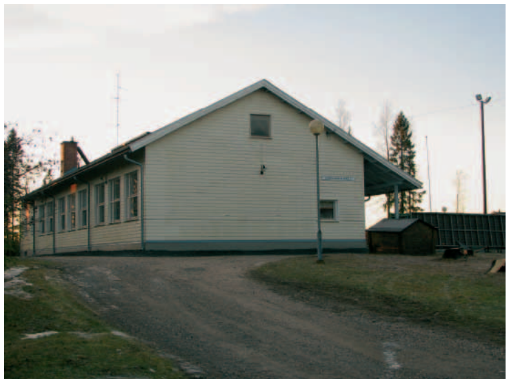
Kantojärven vanha koulurakennus 2006.
