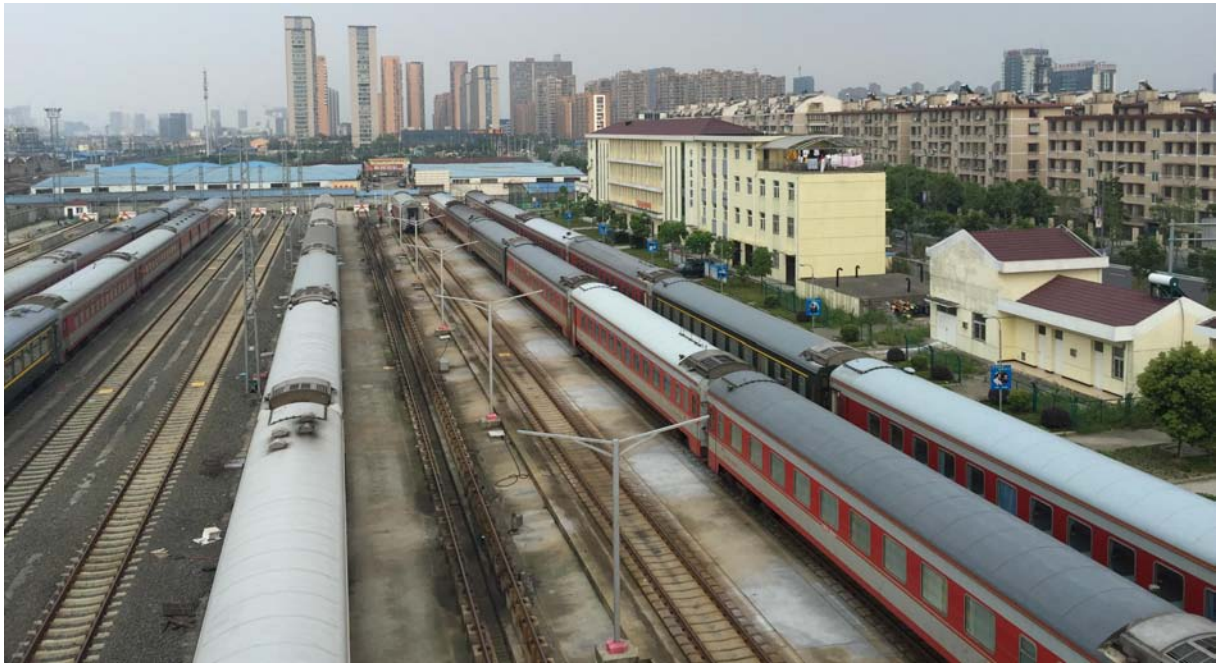
图 2.1-23 宁波东客车整备所现场照片
