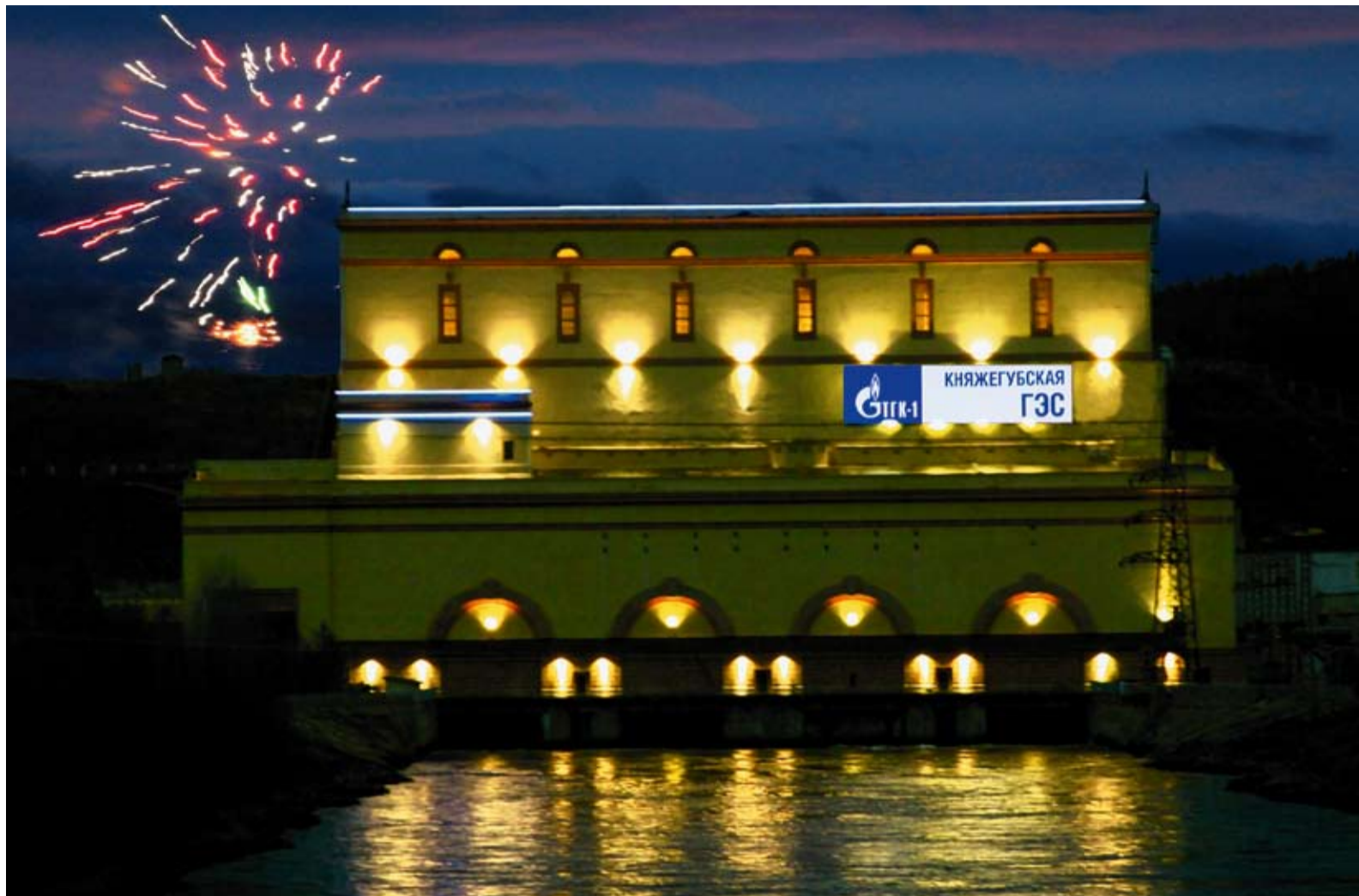
Мощность подсветки – 2,5 кВт. Для сравнения: на охранное освещение идет больше 10 кВт
