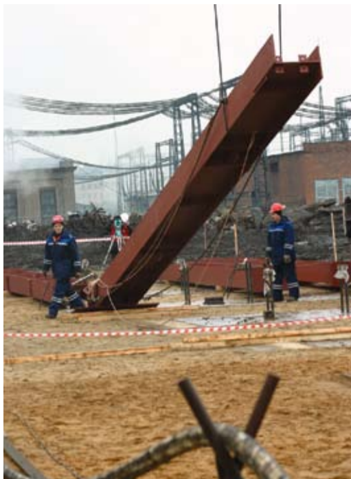
10 апреля 2008 года. Установка первой колонны
