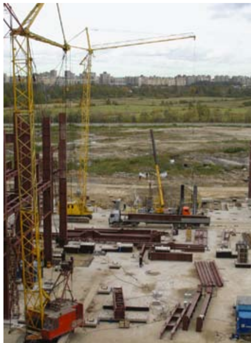
29 сентября 2008 года. Строительство
