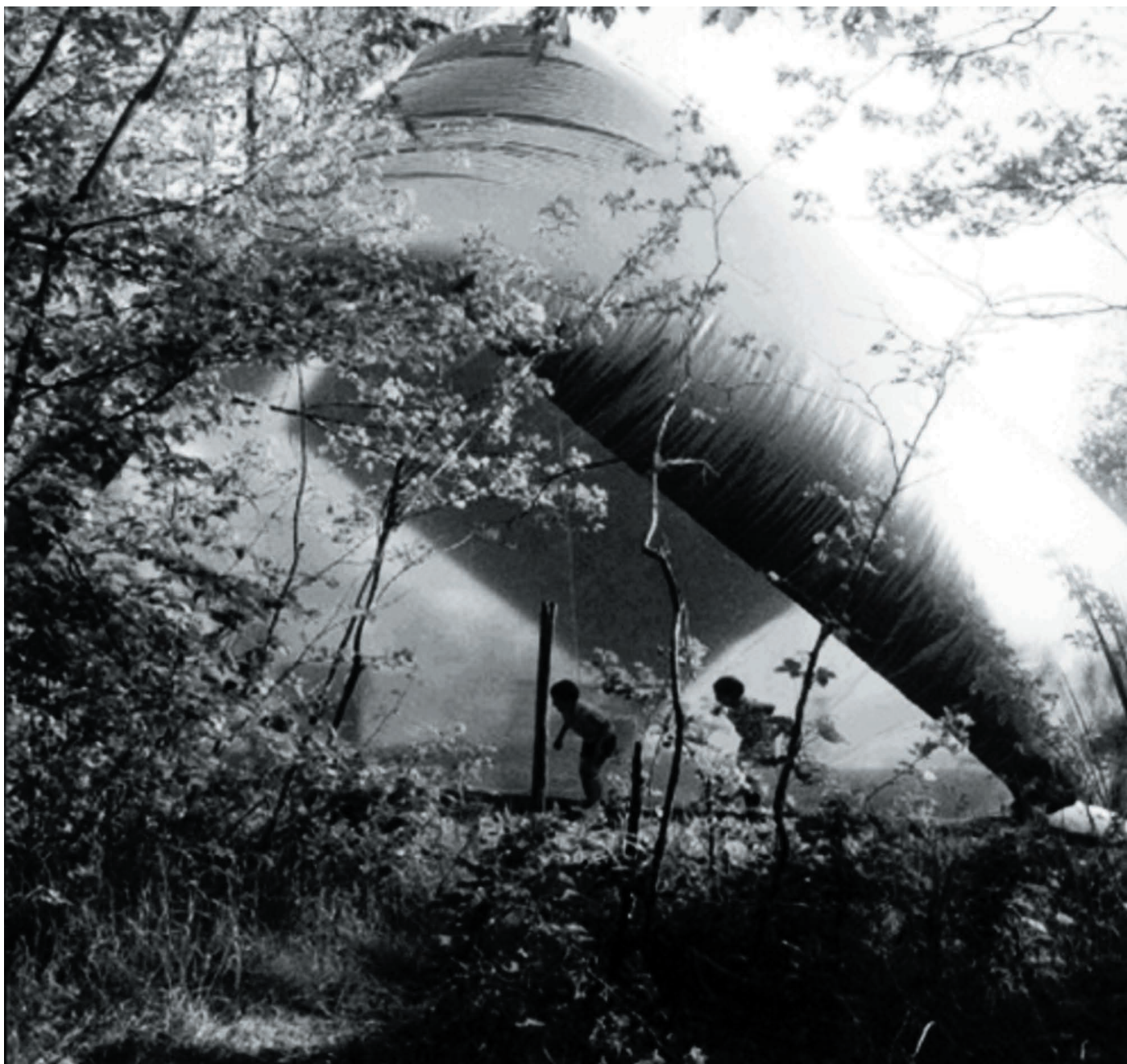
La iglesia tiene planta hexagonal y está realizada en policloruro de vinilo blanco y negro.
