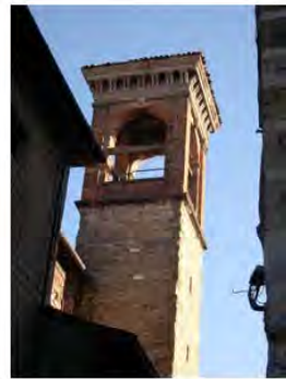
Cono di ripresa n. 9 Campanile
