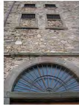
Cono di ripresa n. 6 Particolare della facciata dell'unità edilizia n.5
