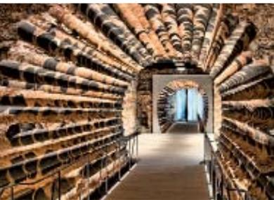
Bohrung durch das Fundament des gotischen Südturmes | © Dombauarchiv Köln, M. Welschenbach
