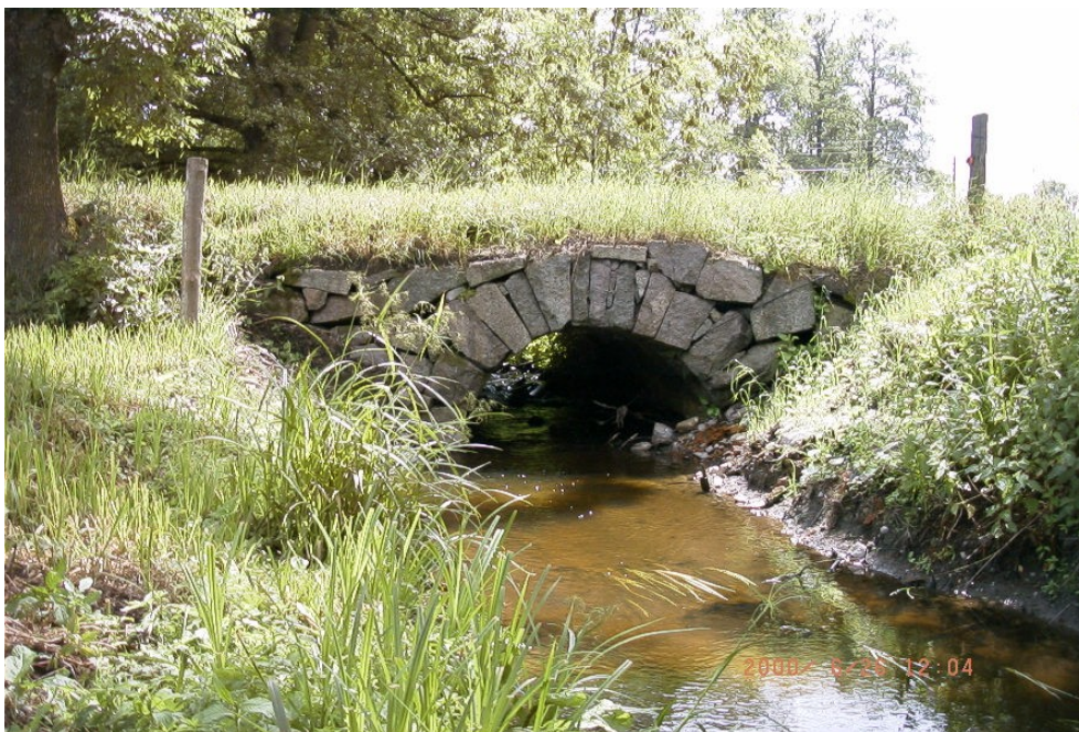
Stenvalvbros i ett spann i bäck från Viksjön i Marströmmens avrinningsområde. Foto taget 2000 i samband med biotopkarteringen, Länsstyrelsen Kalmar.
