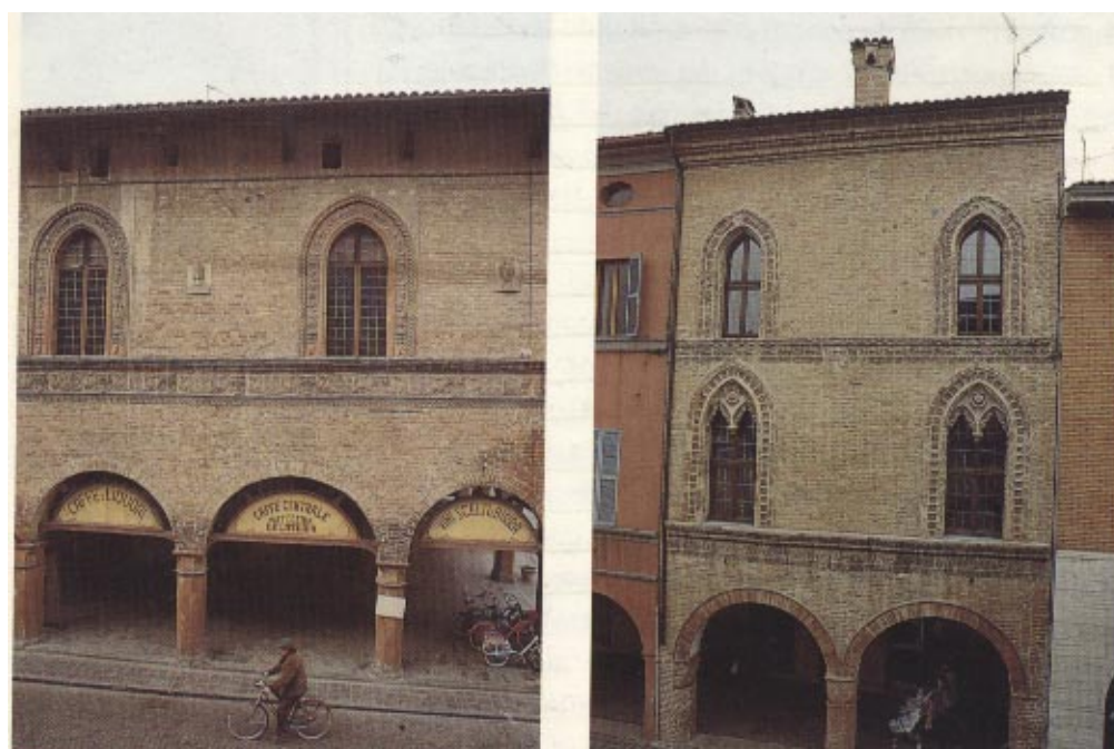
Il vecchio Palazzo Comunale e particolare di una finestra.
