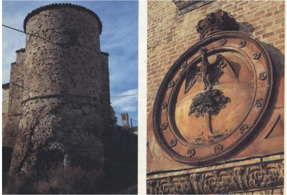
Il torrione di Nord-Est. Lo stemma di Busseto sulla facciata della Rocca.
