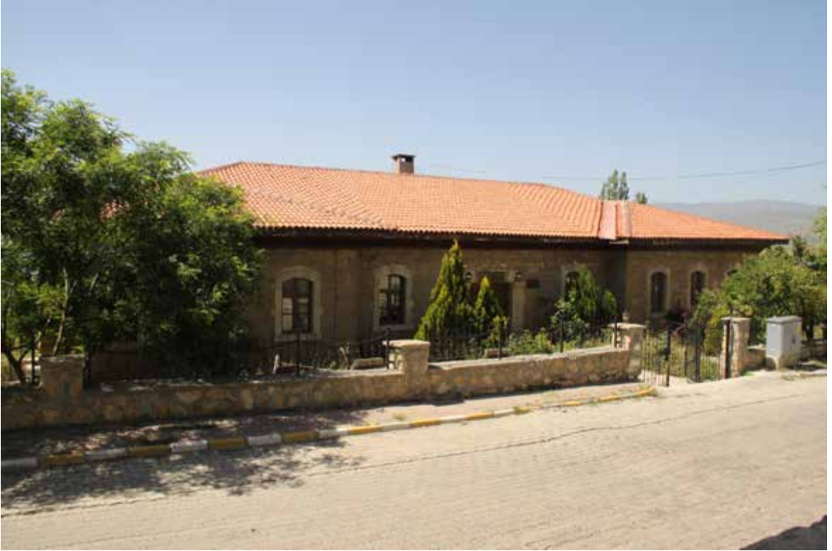
Fotoğraf 51. Gölova Kültür ve Sanat Evi, kuzey cephe, doğudan görünüm
