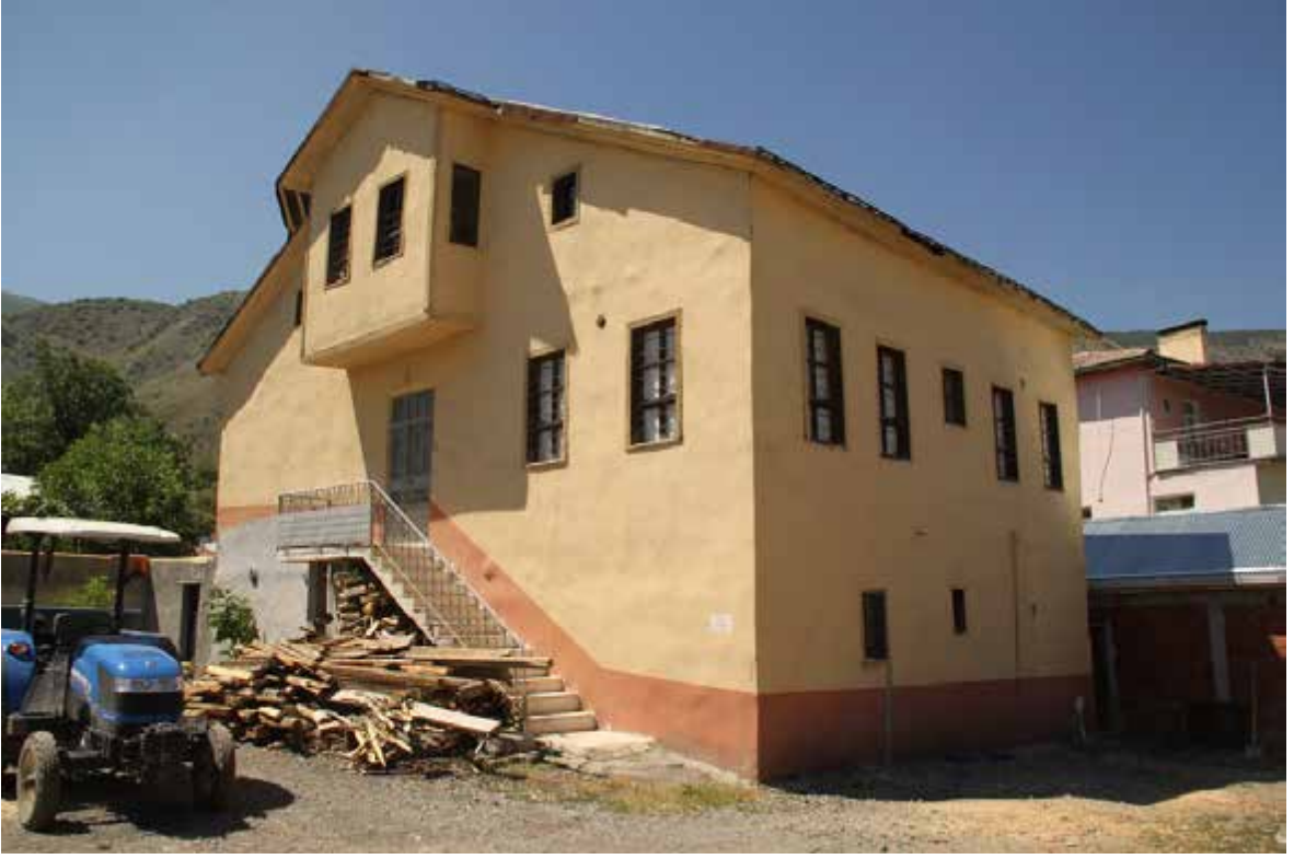
Fotoğraf 1. Cengiz Bektaş Evi, güneydoğudan görünüm
