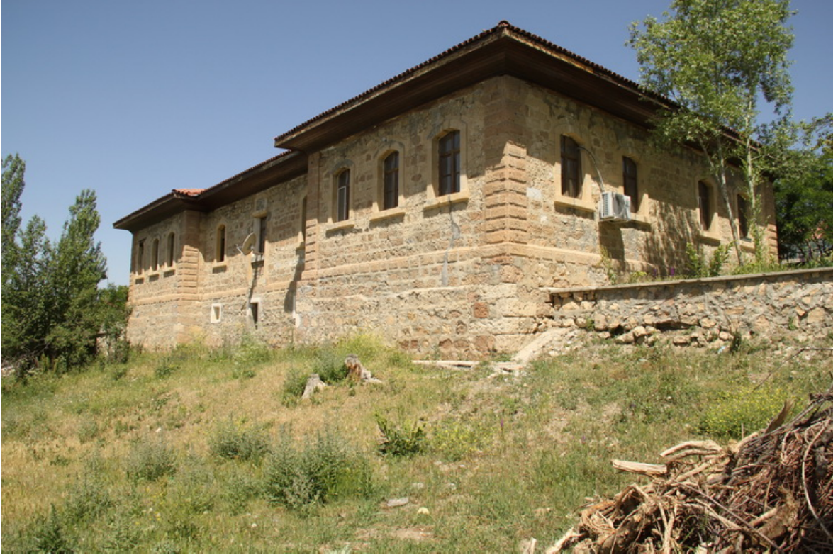
Fotoğraf 55. Gölova Kültür ve Sanat Evi, güney cephe, doğudan görünüm
