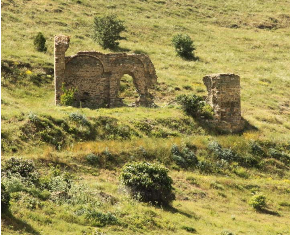
Fotoğraf 106 Dikköy Kilisesi, güneyden genel görünüm
