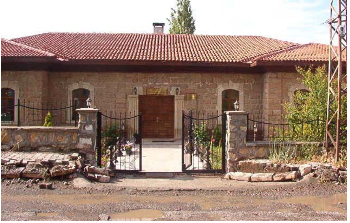
Fotoğraf 52. Gölova Kültür ve Sanat Evi, kuzey cephe
