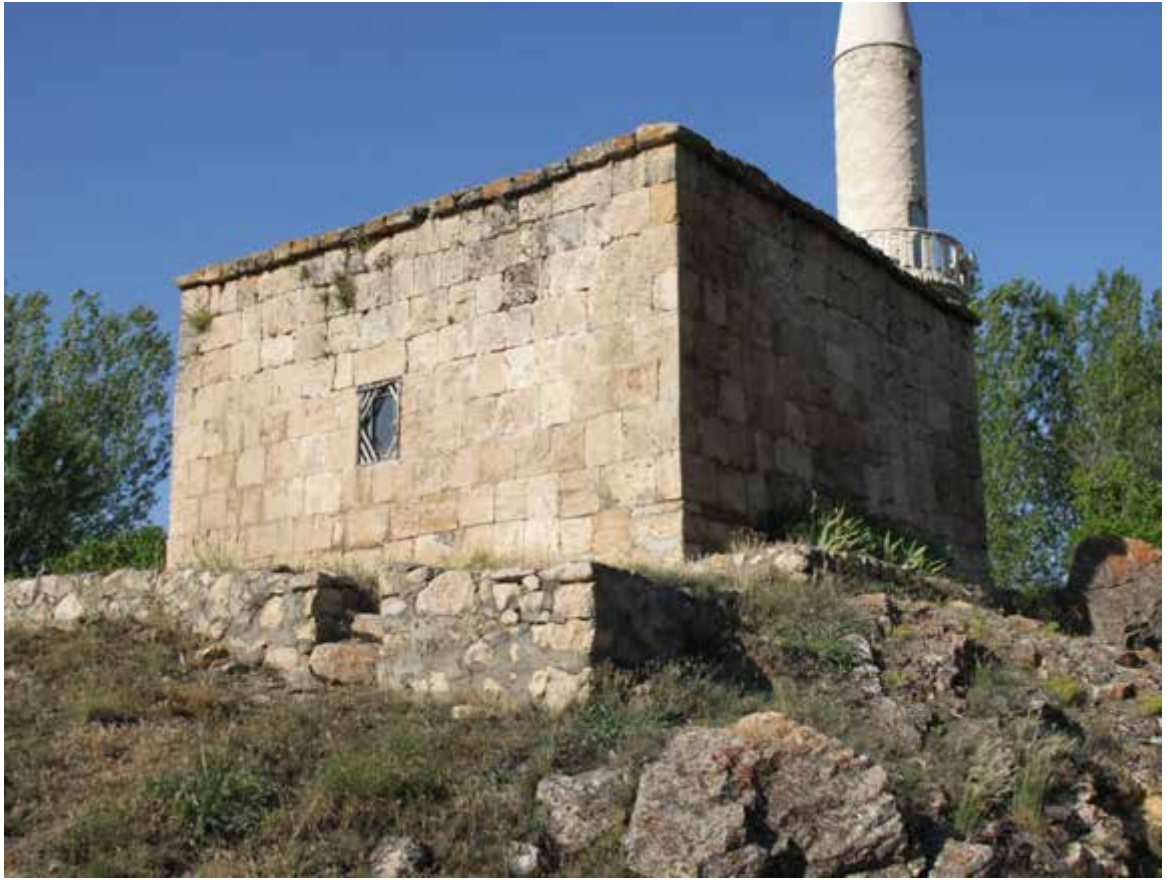
Fotoğraf 97. Çoban Baba Türbesi, doğu ve güney cephe
