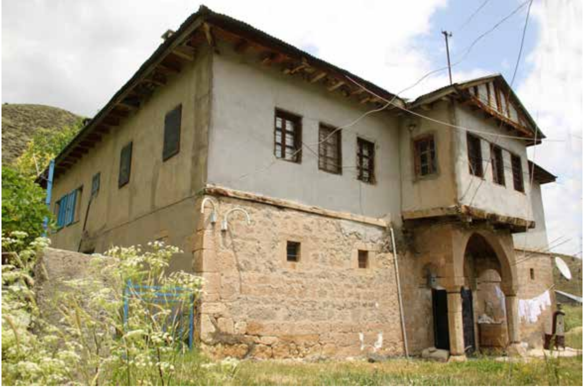
Fotoğraf 117. Subaşı Köyü, Kucur Konağı, güney ve batı cephe
