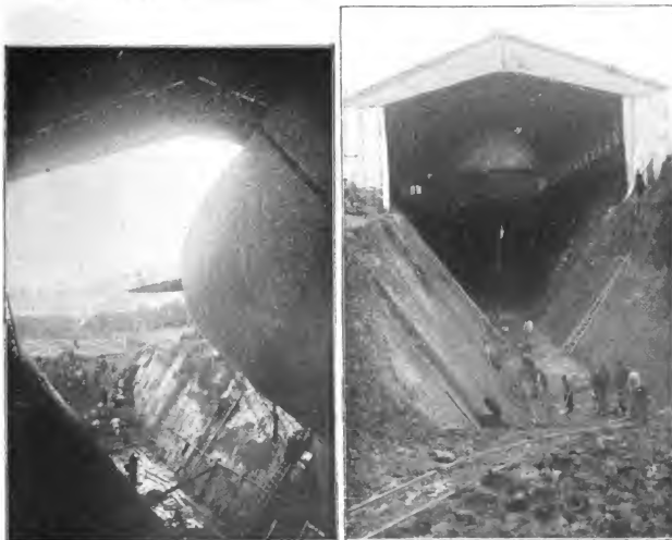
La tranchée qu'il a fallu creuser pour permettre au ballon Lebaudy d'entrer dans le hangar à Toul.
