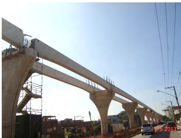
Trecho Oratório – São Mateus (Av. Prof. Luiz Ignácio de Anhaia Mello – CEML): Execução da monolitização das vigas-guia.
