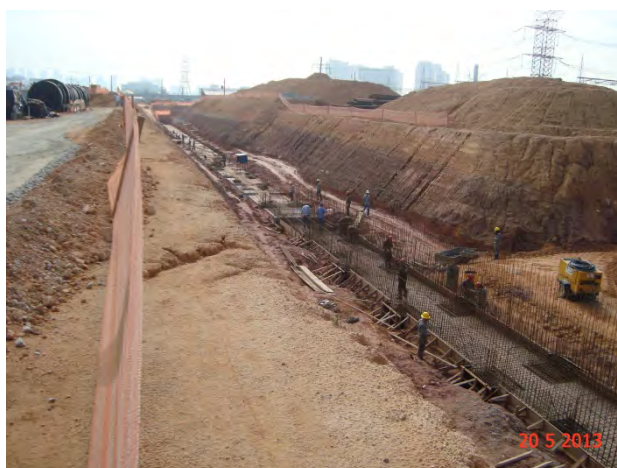
Lote 8 – Pátio Guido Calói: Armação da galeria de utilidades.
