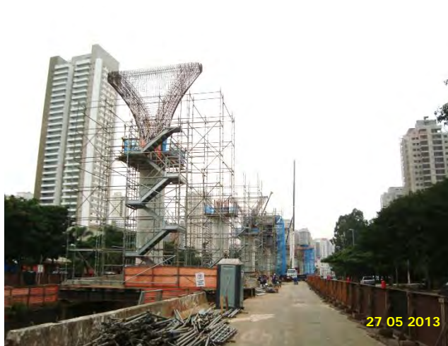
Trecho Campo Belo – Vila Cordeiro: Capitéis em execução.
