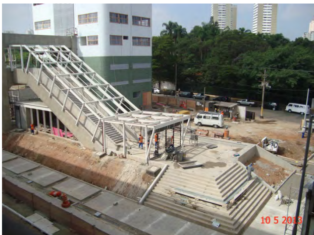
Estação Oratório – Acesso Oratório: Execução do acabamento e da urbanização.
