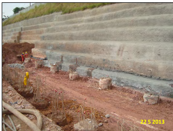
Estação Vila Sônia: Área do muro de arrimo para desvio de tráfego
