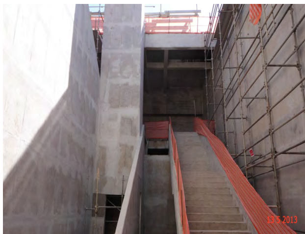
Lote 1 – Estação Adolfo Pinheiro - Acesso A: Execução das estruturas internas
