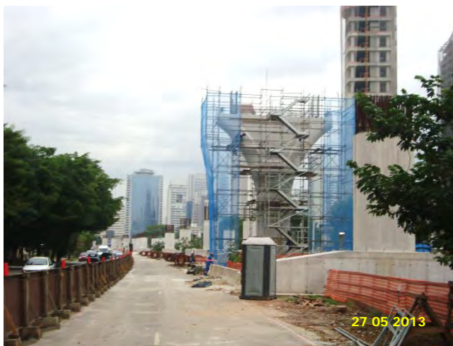
Trecho Campo Belo – Vila Cordeiro: Capitel em executado.
