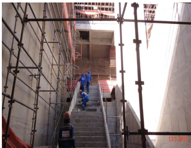
Lote 1 – Estação Adolfo Pinheiro - Acesso B: Execução das estruturas internas
