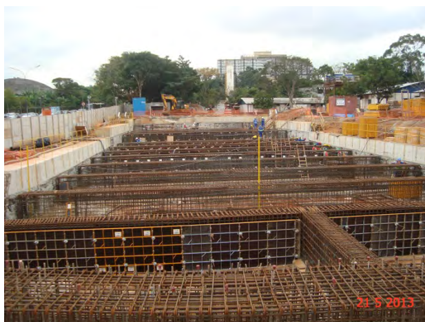
Lote 6 – Estacionamento de Trens Servidor: Execução da armação da estrutura de cobertura para a escavação do VCA
