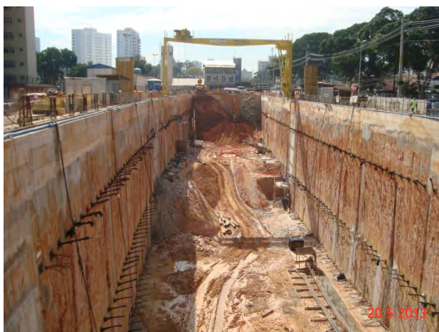
Lote 2 – Estação Alto da Boa Vista: Escavação do VCA do corpo da estação
