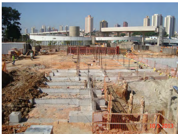
Estação Vila Prudente: Execução da fundação e pilares das Salas Técnicas.
