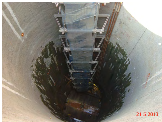
Lote 7 – VSE Joel Jorge de Melo: Concretada a laje de fundo
