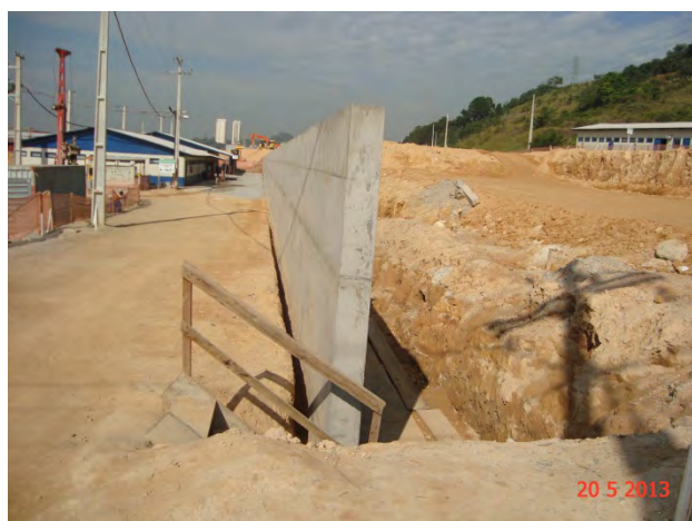
Lote 8 – Pátio Guido Calói: Concretado o muro de arrimo, atrás do Bloco G.
