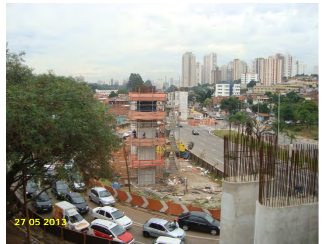
Trecho Jardim Aeroporto – Brooklin Paulista: Pilares em execução.
