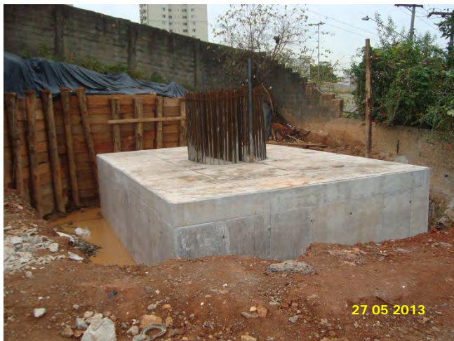
Trecho Congonhas – Brooklin Paulista: Bloco em concluído.
