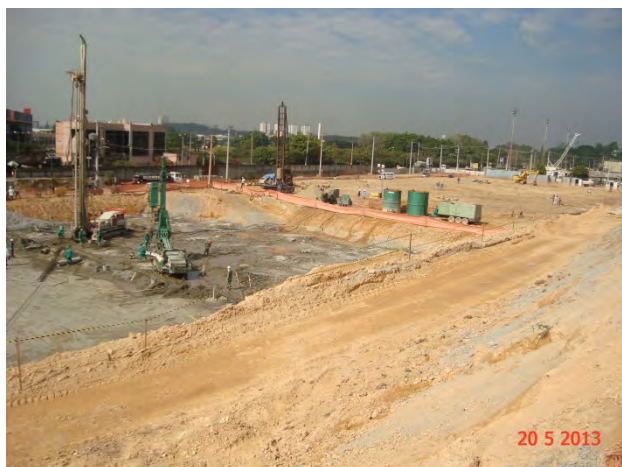
Lote 8 – Pátio Guido Calói – Bloco A: Execução das fundações
