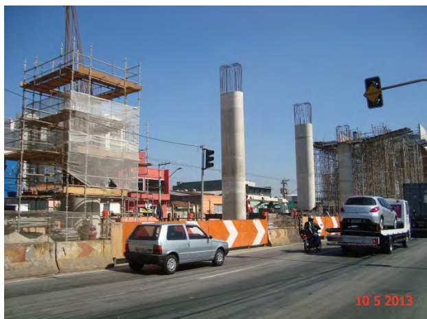
Trecho Vila Prudente – Oratório: Execução dos pilares e cimbramento da laje do Track Switch.
