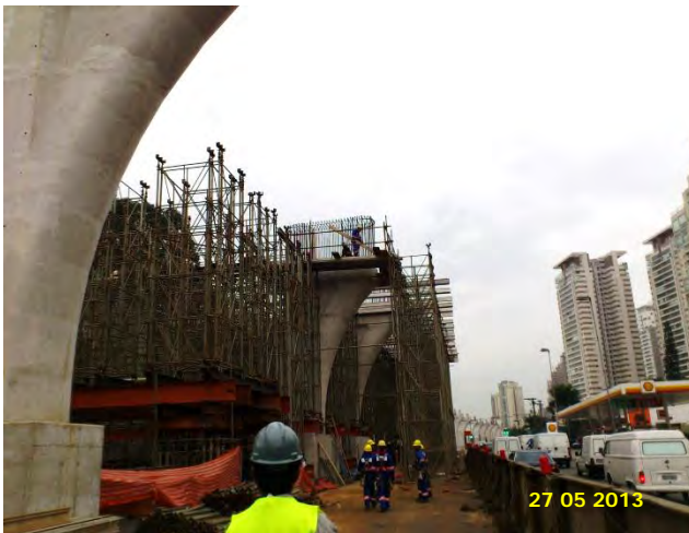
Trecho Brooklin Paulista – Vereador José Diniz: Capitéis executados. Em execução a laje do track-switch
