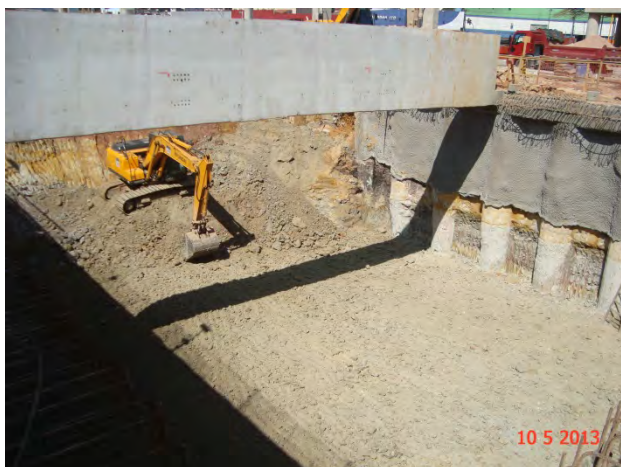
Estação Vila Prudente – Acesso de Interligação: execução da escavação do VCA.
