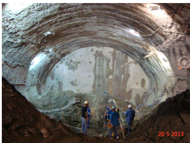
Lote 3 – VSE Roque Petrella: Escavação do túnel de via sentido Norte, em NATM
