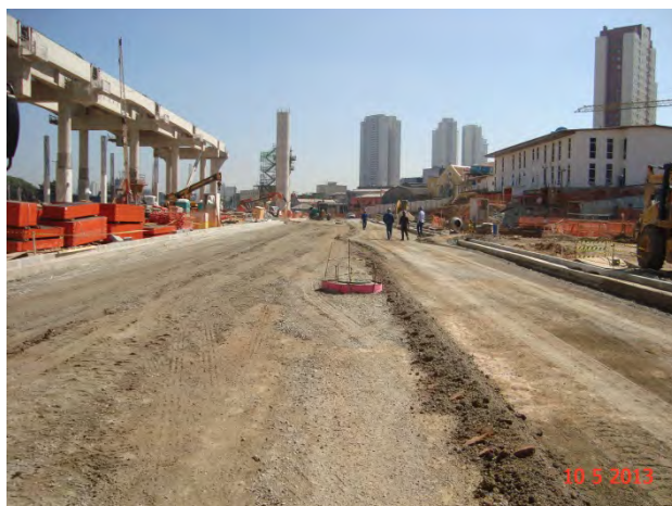
Estação Vila Prudente: Execução do pavimento do desvio de tráfego.
