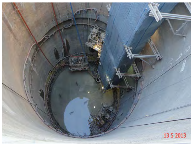
Lote 2 – VSE Paulo Eiró: Concretada a laje de fundo
