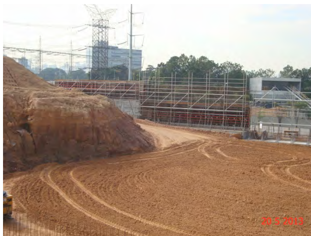
Lote 8 – Pátio Guido Calói: Execução de terraplenagem
