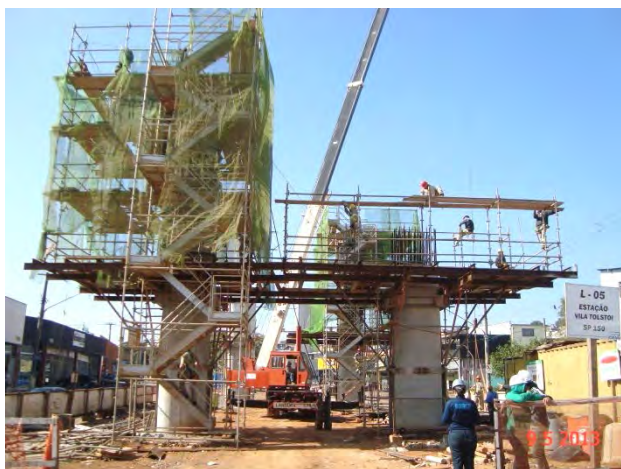
Trecho Oratório – São Mateus (Av. Prof. Luiz Ignácio de Anhaia Mello – CEML): Execução de pilares e capitéis da via.
