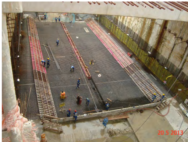
Lote 3 – VSE Bandeirantes: Concretada a seção 3 da laje de fundo
