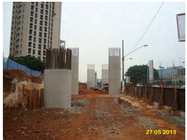
Trecho Congonhas – Brooklin Paulista: Pilares em execução.
