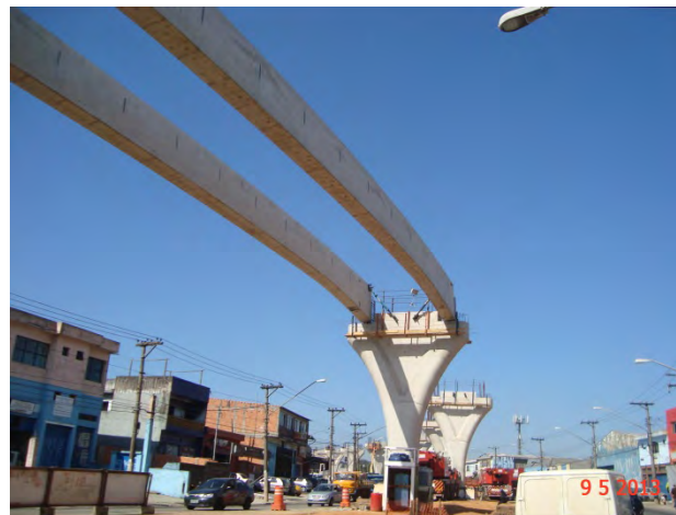
Trecho Oratório - São Mateus (Avenida Sapopemba): Lançamento das vigas-guia.
