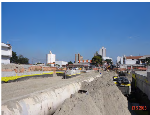
Lote 1 – Estação Adolfo Pinheiro: Aterro sobre a laje de cobertura em execução
