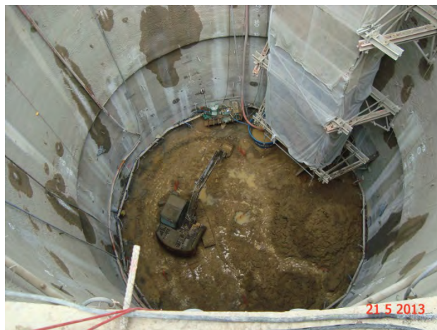
Lote 5 – VSE Rouxinol: Escavação do poço
