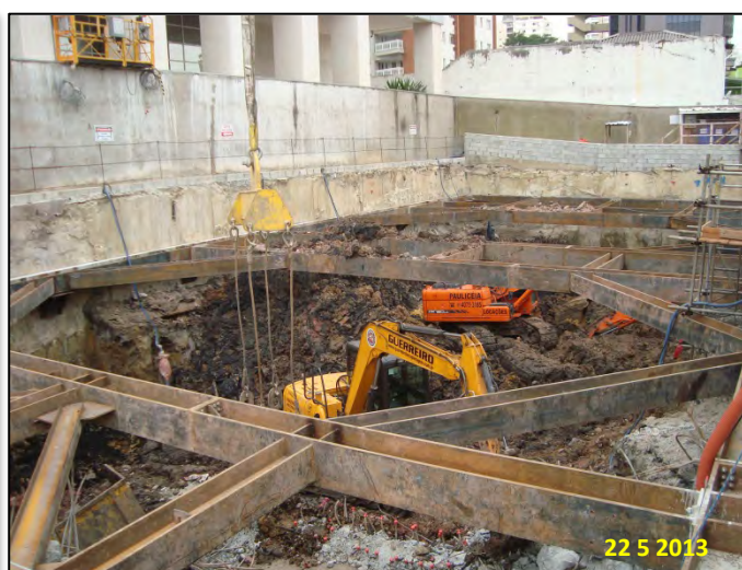
Estação Fradique Coutinho – Acesso Fradique: Escavação do acesso
