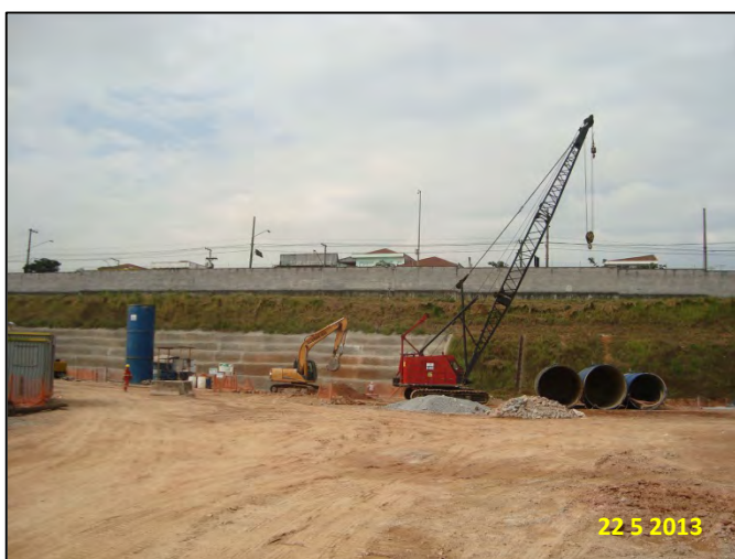
Estação Vila Sônia: Área da estação
