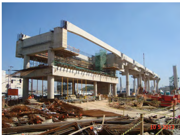
Estação Vila Prudente: Execução do reforço das estruturas e das paredes vigas do mezanino.
