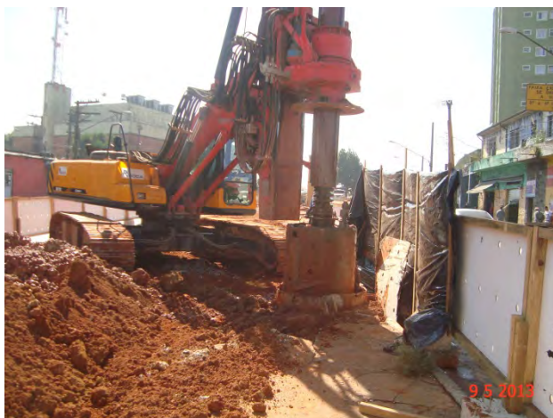
Trecho São Mateus - Iguatemi (Avenida Ragueb Chohfi): Execução dos estações dos pilares da via.
