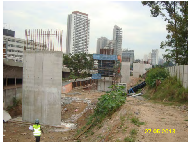
Trecho Vila Cordeiro – Chucri Zaidan: Pilares em execução.
