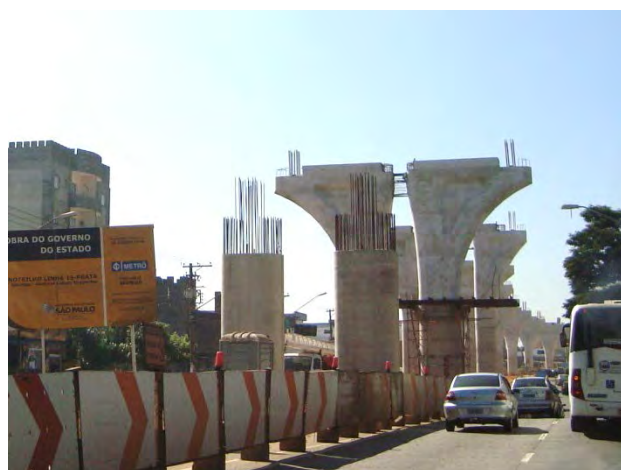
Trecho Oratório - São Mateus (Avenida Sapopemba): Execução dos pilares e capitéis da via.
