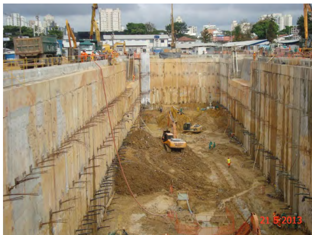
Lote 5 – Estação Eucaliptos: Escavação do VCA do corpo da estação
