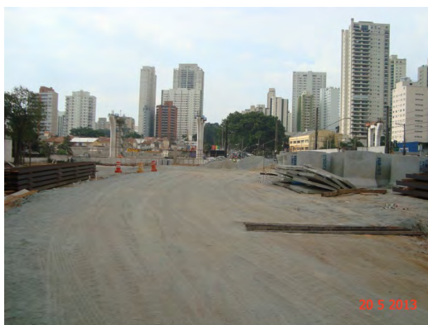
Lote 4 – Estação Campo Belo: Execução do desvio de tráfego – Lado Sul
