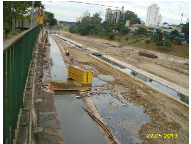
Trecho Vila Paulista – Jardim Aeroporto: desvio do córrego Água Espriada na região do Piscinão.
