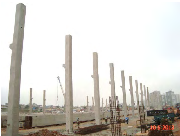
Pátio Oratório: Execução das estruturas de concreto do Bloco A (Oficina de Trens). Detalhe dos pilares pré-moldados e das vigas da via.
