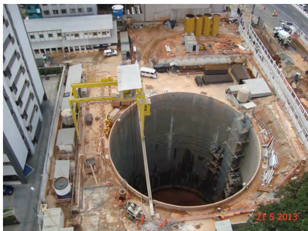
Lote 7 – Estação Santa Cruz: Escavação do Poço 1 do corpo da estação
