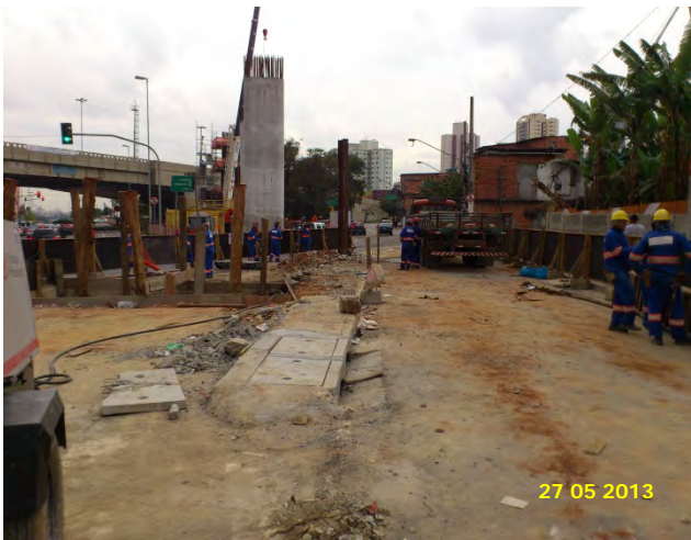
Trecho Jardim Aeroporto – Brooklin Paulista: Alteração do viário para implantação do monotrilho.
