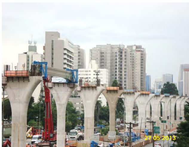
Trecho Vereador José Diniz – Campo Belo: Início do lançamento das vigas-guia
