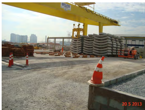
Fábrica de Anéis do Shield - Lote 7: Área de estocagem dos anéis
