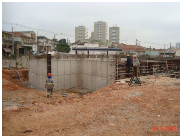
Pátio Oratório: Execução das estruturas do porão de cabos do Bloco D2 (Casa de Sinalização e Telecomunicações).
