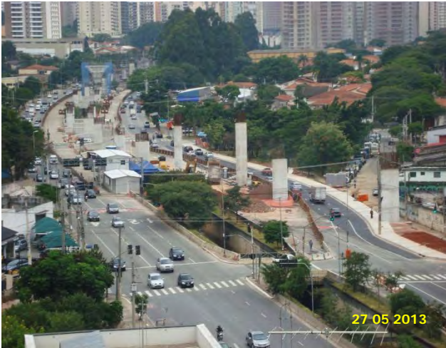
Trecho Vila Cordeiro – Chucri Zaidan: Desvio de tráfego executado.
