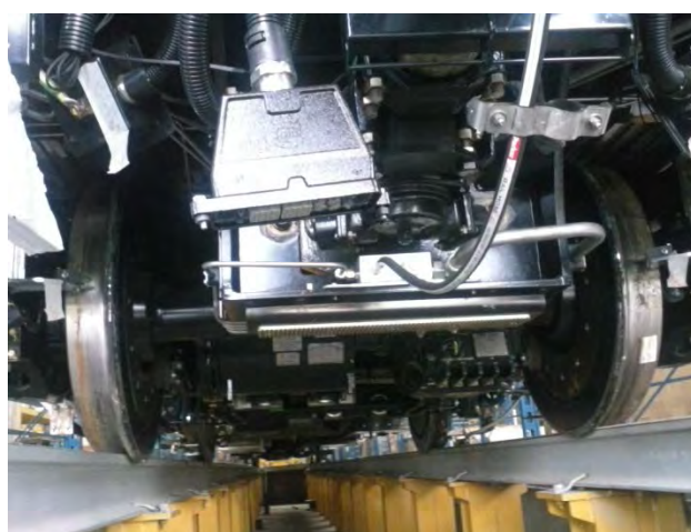
Detalhe sob o estrado do Carro A1 do 1º trem.
