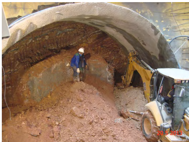
Lote 2 – VSE Alexandre Dumas: Execução da escavação do túnel de ligação
