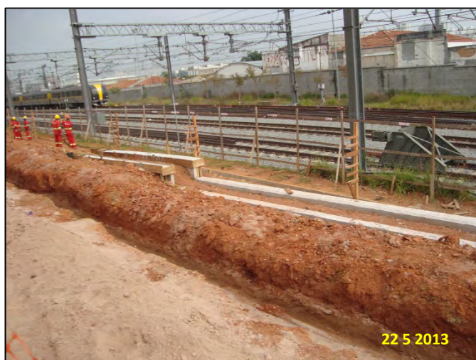
VCA Vila Sônia: Execução da guia para a parede diafragma e remoção de interferências
