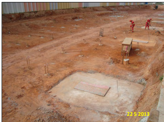
Pátio Vila Sônia – Bloco A: Estacas e blocos de fundação concluídos
