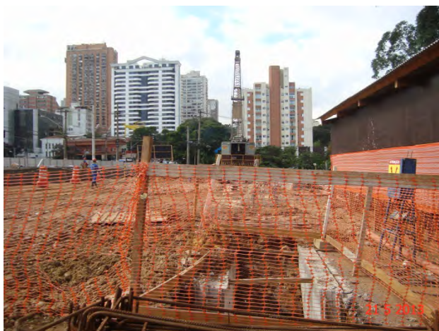
Lote 6 – Estação AACD - Servidor: Execução da parede diafragma
