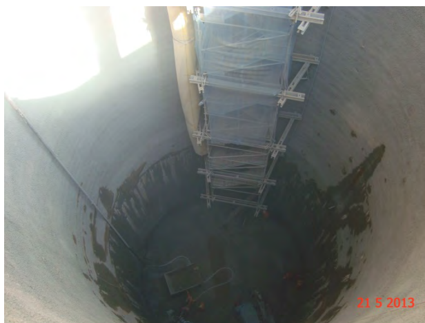
Lote 7 – VSE Botucatu: Escavação do poço
