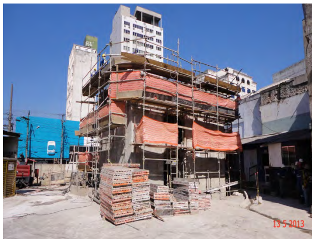
Lote 1 – VSE Delmiro Sampaio: Concluído o revestimento secundário e a escada interna do poço. Estruturas externas em execução.
