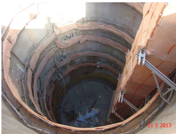
Lote 6 – VSE Magalhães: Concretada a laje de fundo
