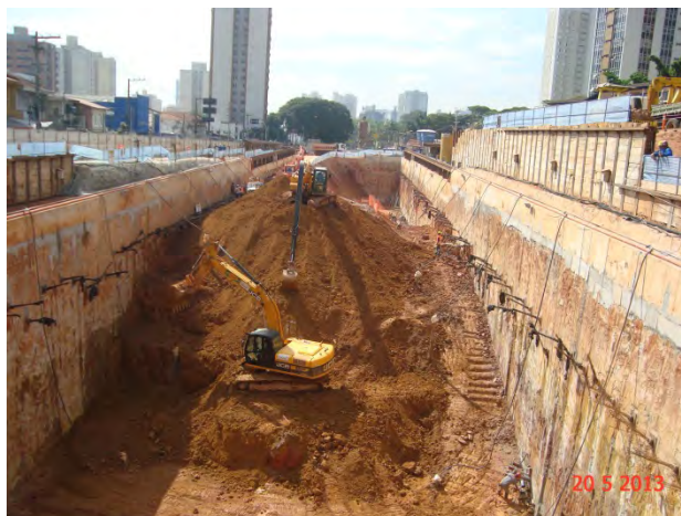
Lote 2 – Estação Borba Gato: Escavação do VCA do corpo da estação
