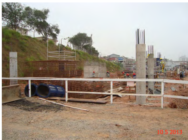
Pátio Oratório: Execução das fundações e pilares do Bloco B (Administração).
