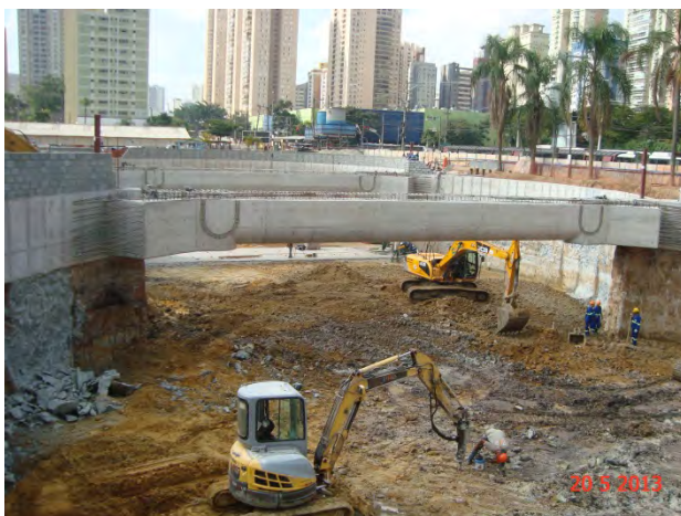
Lote 3 – Estação Brooklin: Escavação do VCA do corpo da estação
