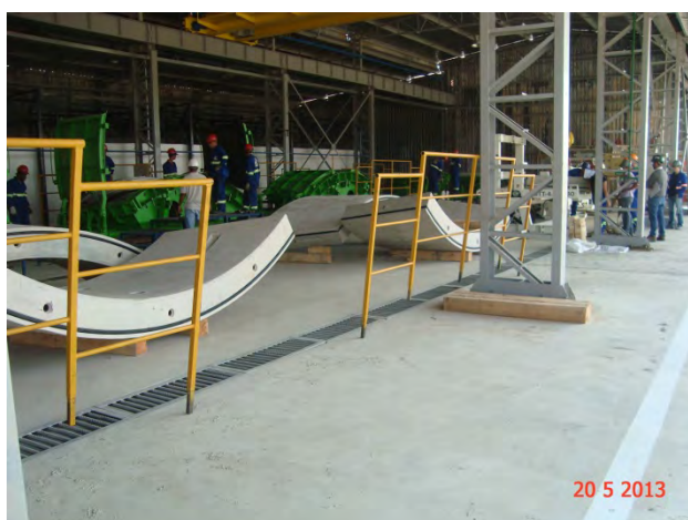
Fábrica de Anéis do Shield - Lote 3: Testes para fabricação dos anéis
