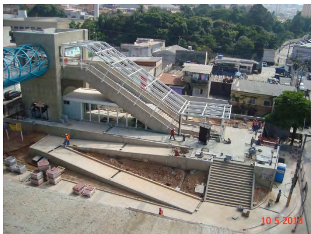
Estação Oratório – Acesso Nupeba: Execução do acabamento e da urbanização.
