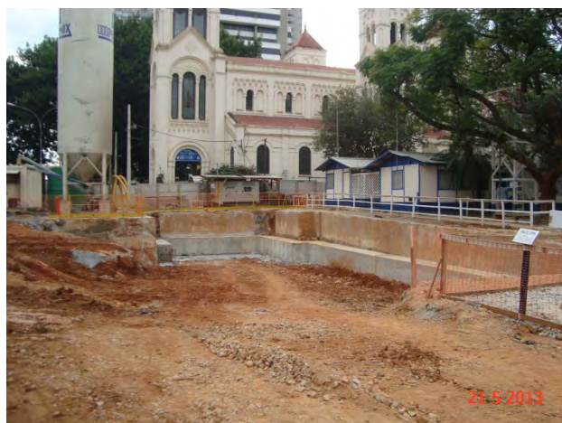
Lote 5 – Estação Moema: Execução da viga de coroamento
