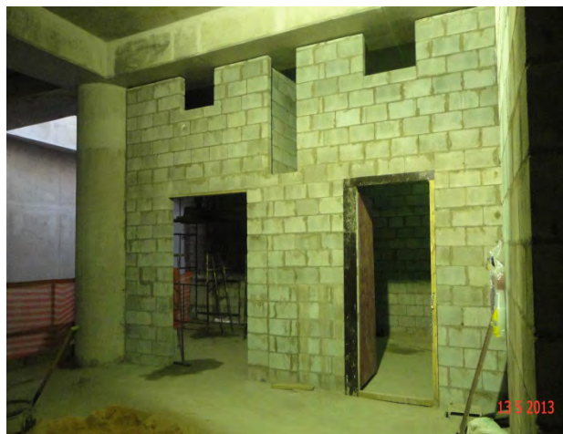
Lote 1 – Estação Adolfo Pinheiro: Fechamento com alvenaria das salas operacionais
