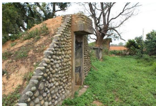
作戰指揮所入口全景
