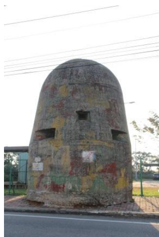
圖 3-39：日軍望高寮僅存作戰工事
