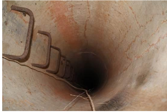
地下指揮所西側地道出口的攀爬梯
