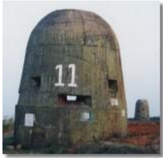
已拆除的編號 11 號機槍堡
