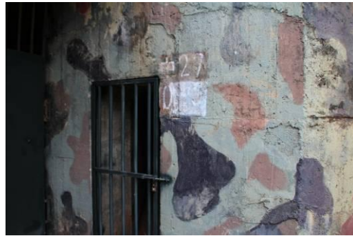
砲堡內部一側的避彈室
