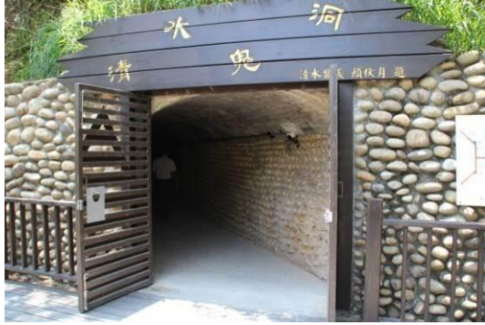
日軍地底工事入口
