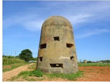
已拆除的編號 12 號機槍堡
