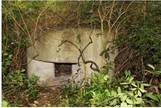
地下指揮所西側地道出口
