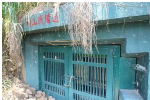
圖 6— 2：具穿透性的鐵柵欄圍籬
