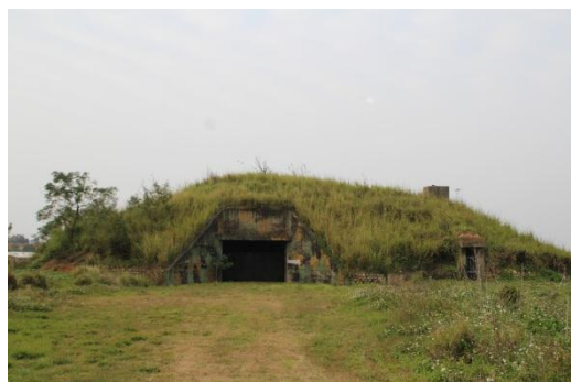
圖 5— 4：砲入口大面積開闊地
