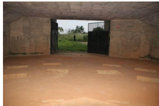
砲堡內不，望向進入口
