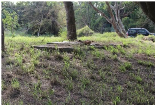
地下指揮所入口用鐵片蓋住
