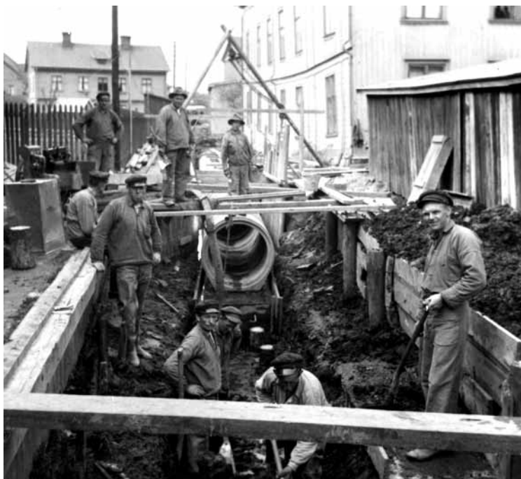
Pågående igenfyllning av Junebäcken söder om Västra Storgatan. Bild: Jönköpings kommun
