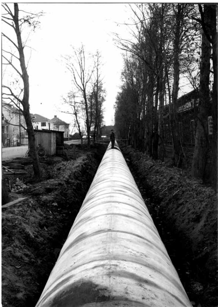
Vid kulverteringen av Junebäcken år 1934 i Junegatan pålades bäckfåran och på dessa pålar anordnades en gjuten underbädd på vilken kulverten anlades. Bäckfåran beskrevs vara på sina ställen full av dy. Foto från korsningen Stenbergsgatan mot norr. Bild: Jönköpings kommun.
