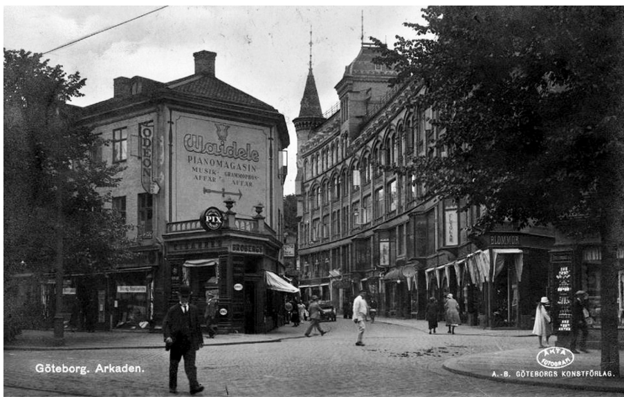
Arkaden – en privatägd stadsgata som aldrig blev färdigbyggd. Vykort 1920.
