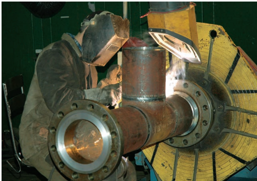
Сварка узла трубопровода
