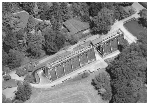
Sanierung des Salzkottener-Wahrzeichens Frühjahr 2015
