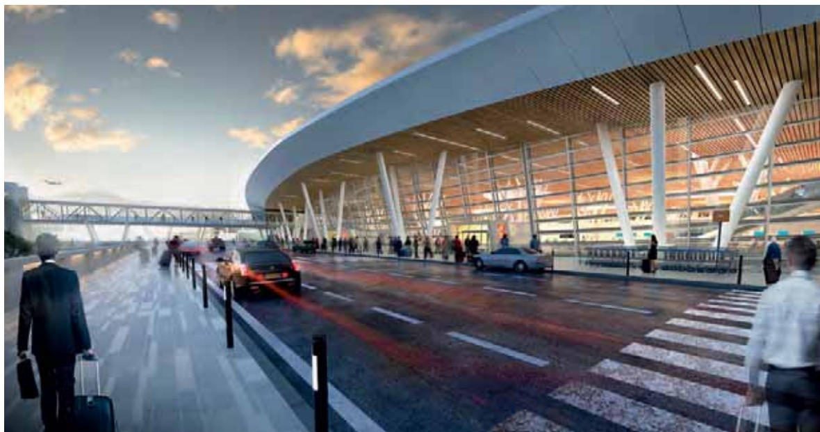
Les travaux de construction et de rénovation doivent démarrer à l'été 2016, après une phase d'études très courte.
