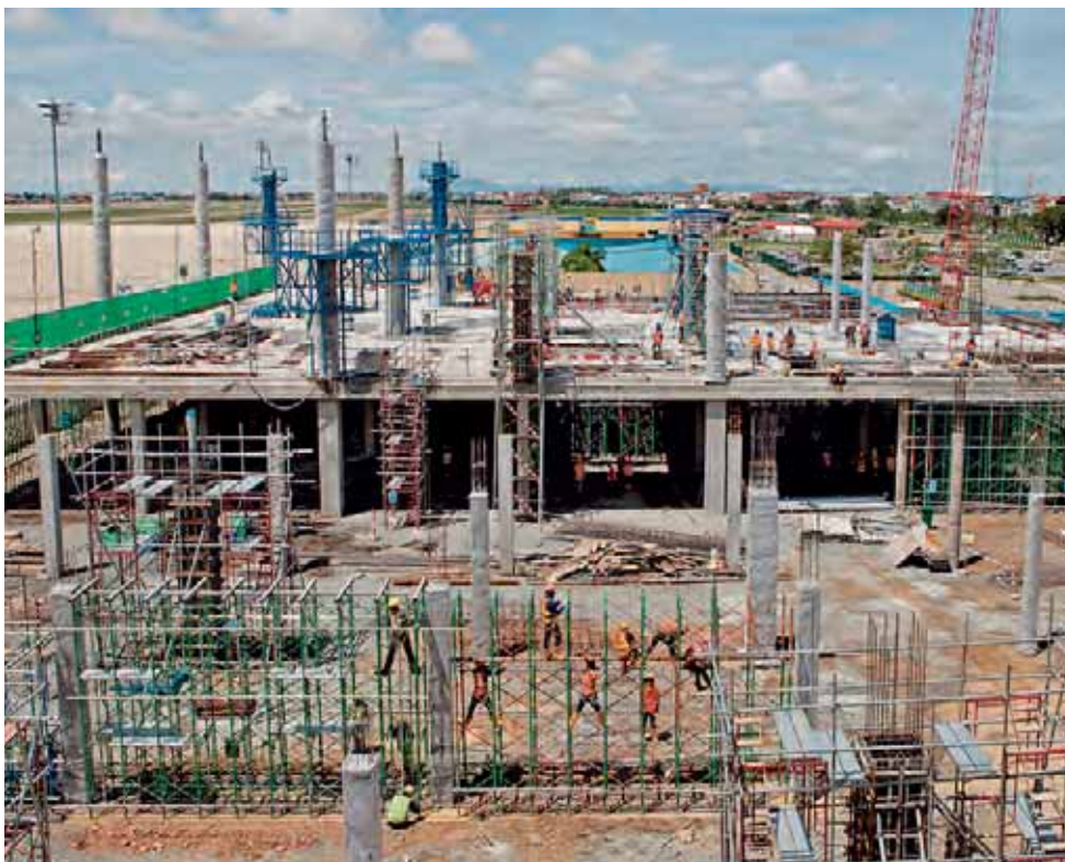
En prenant l'initiative d'ambitieux travaux d'agrandissement au Cambodge, VINCI Airports a pu anticiper et absorber la croissance très forte du trafic.
