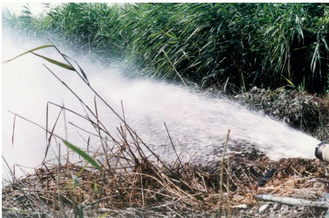
Εικόνα 31: Φωτογραφία κατά την άντληση
