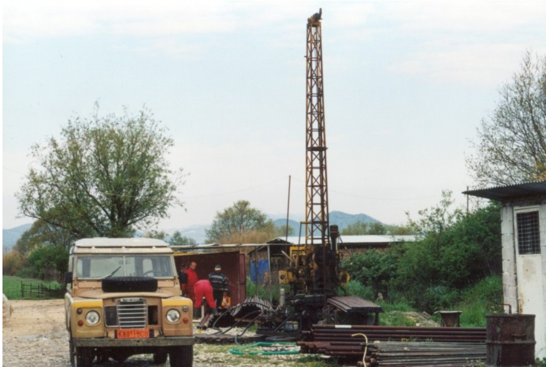
Εικόνα 13: Εργοτάξιο γεώτρησης Ανέζα 1
