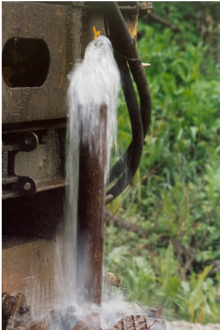
Εικόνα 27: Αρτεσιανισμός στη γεώτρηση ΓΛ-1
