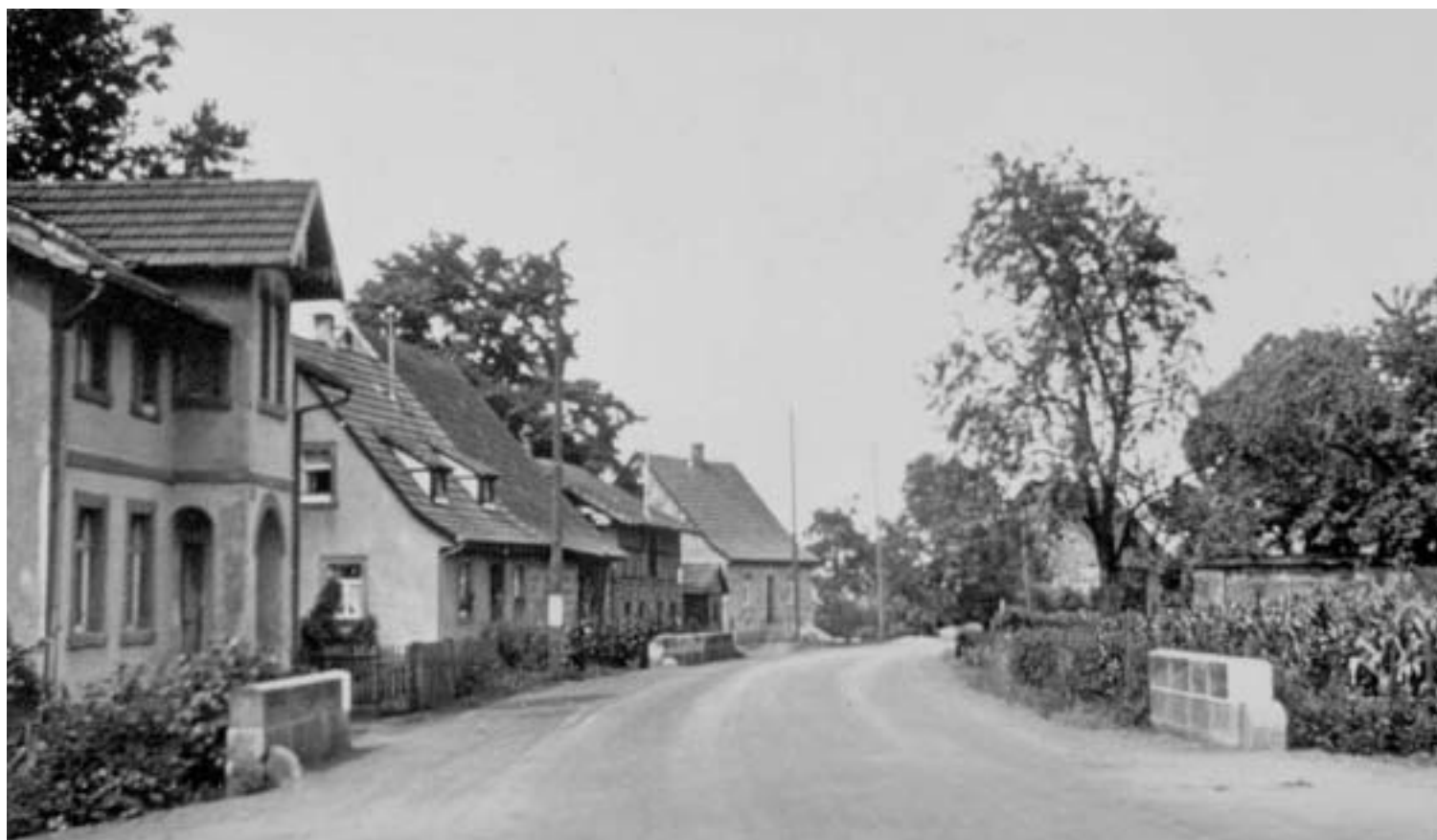
Brücke über den Leiterbach, der Übergabeort für Verbrecher
