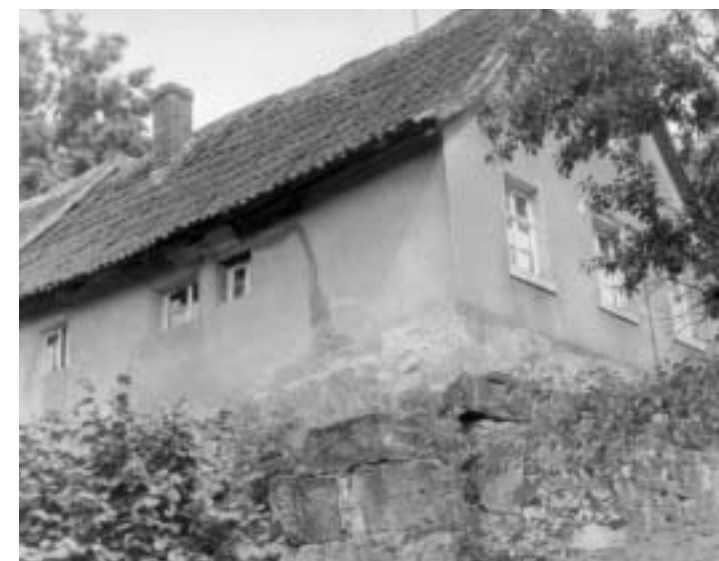
Haus Nr. 47 (Reifengarten 1), dessen Sockel Teile der ehemaligen Burg enthielt
