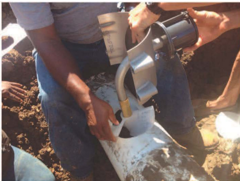
Step 4: Install Meter
