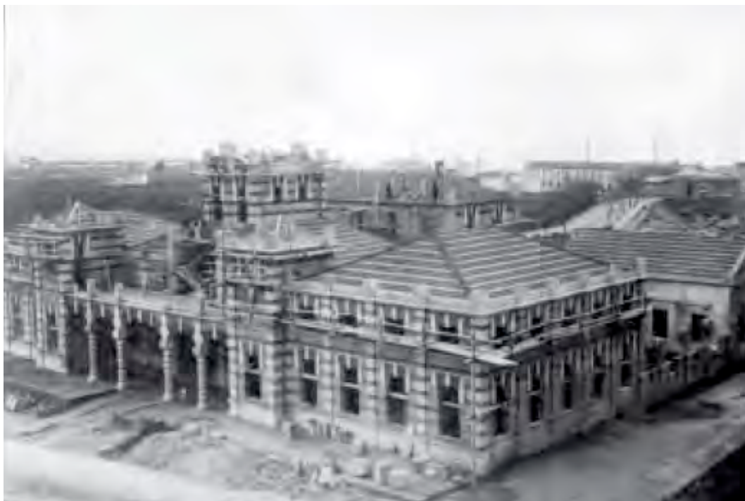
Escola Graduada de Palma en construcció (1912)
