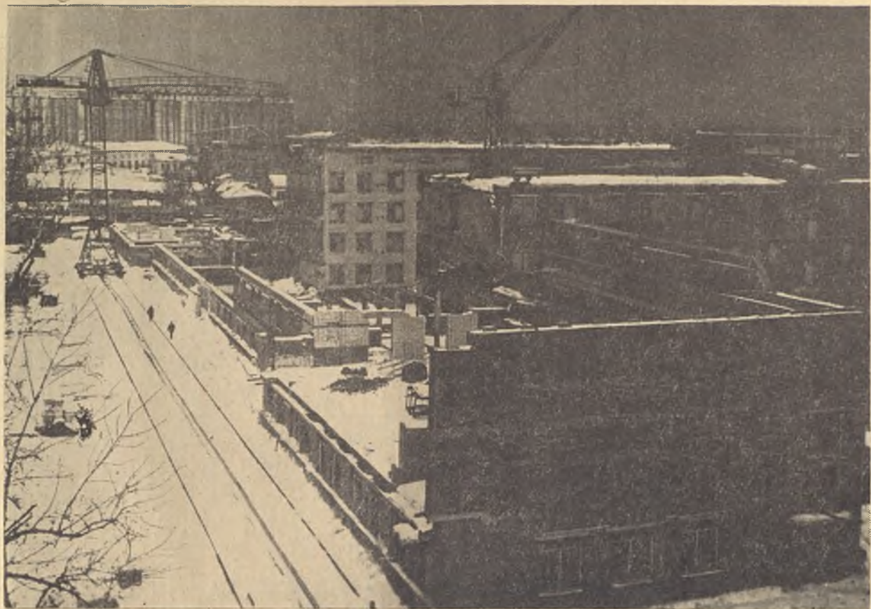
Строительство учебного корпуса университета (1966 г.).
