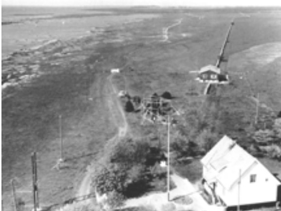
Krattet byggs, bilden tagen 12 september 1949 (foto: Knut Borg).
