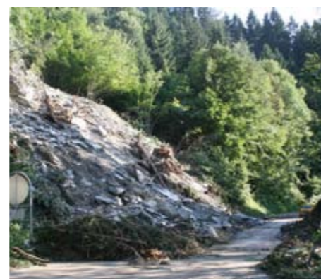
Während der Aufräumarbeiten: Bagger befreiten den Hang von losem Geröll.
