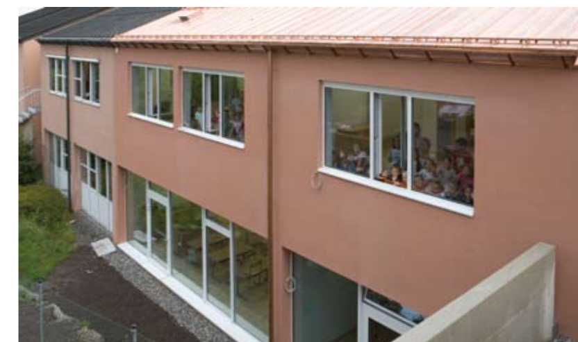
Glänzendes Kupferdach: Der neue Teil ist gut zu erkennen. (Foto: Klaus Defner)
