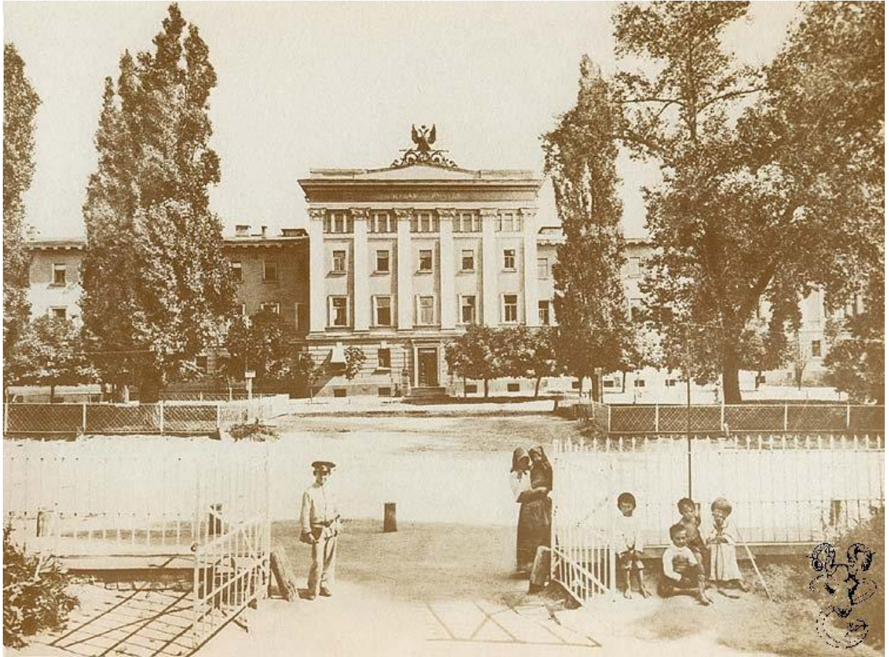
Будівля Першої київської чоловічої гімназії, де В. Липинський навчався у 1900 – 1902 рр.
