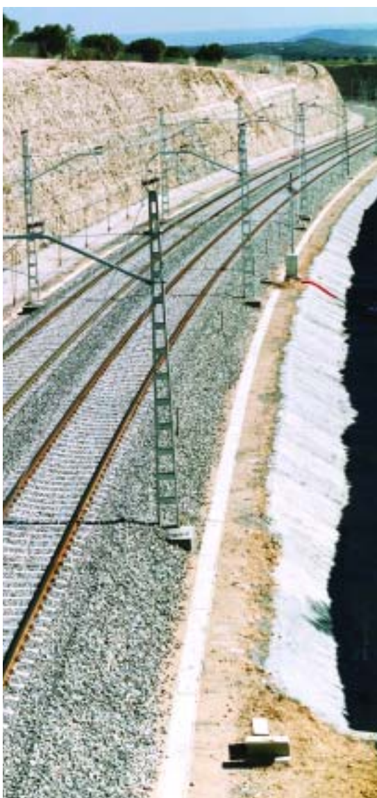
Acceso ferroviario a Parque Temático de San Martín de la Vega. Madrid.
