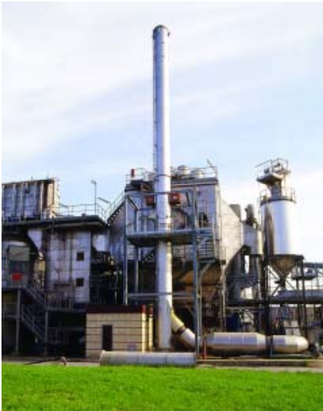
Estación depuradora de aguas residuales de Galindo.
