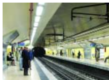
Remodelación estación de metro Diego de León. Madrid.
