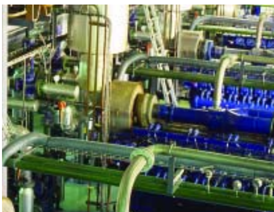
Planta de cogeneración con motores de gas y turbina para Ampo. Guipúzcoa.
