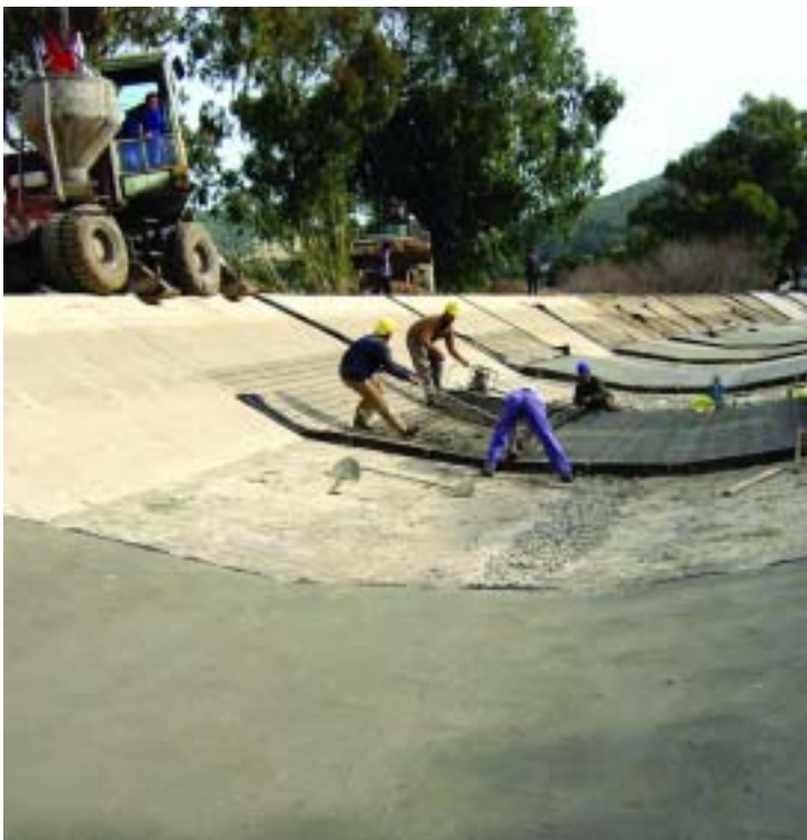
Construcción del Canal de Guadalquivir. Cádiz.
