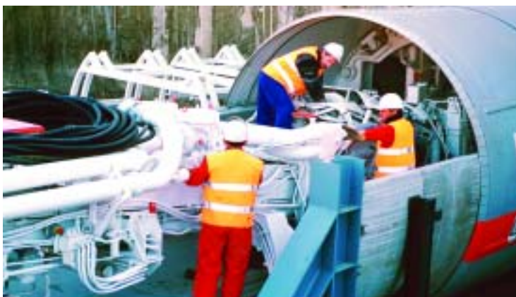
Tuneladora. Ensanche de Vallecas. Madrid.
