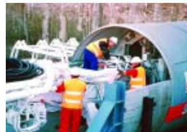
Tuneladora. Ensanche de Vallecas. Madrid.
