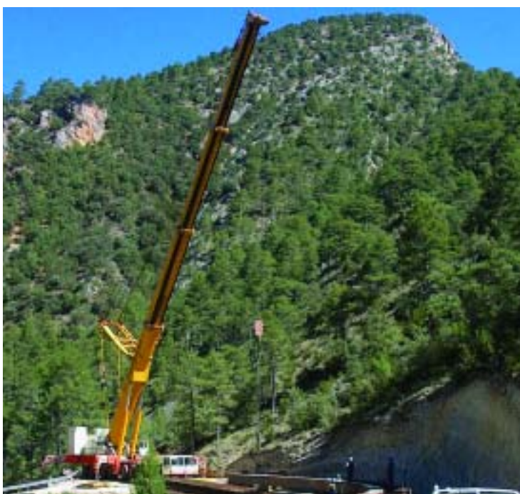
Acondicionamiento carretera de Poveda-Taravilla. Guadalajara.
