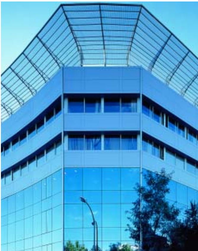
Edificio Pedro de Valdivia. Madrid.
