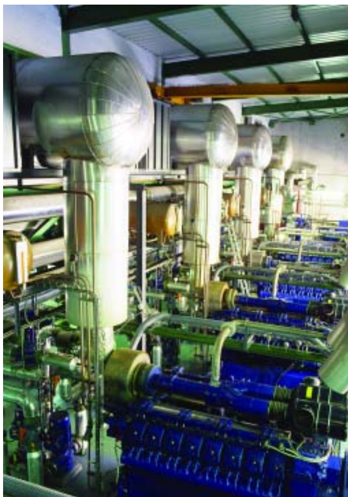
Planta de cogeneración con motores de gas y turbina para Ampo. Guipúzcoa.
