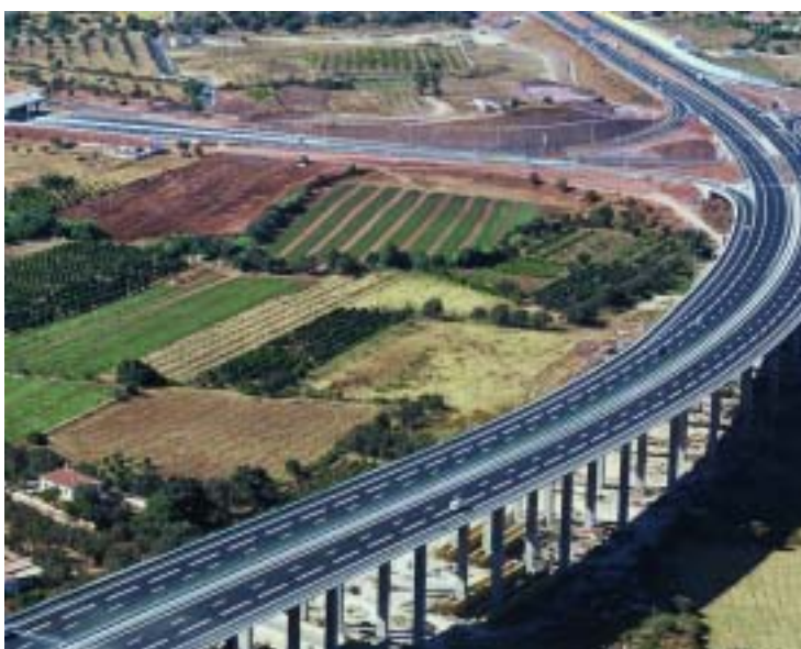
Autopista A-2 Sur. Portugal.
