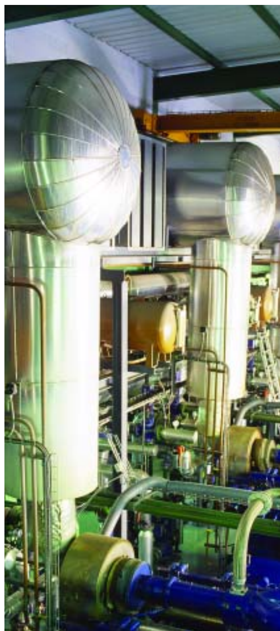
Planta de cogeneración con motores de gas y turbina para Ampo. Guipúzcoa.
