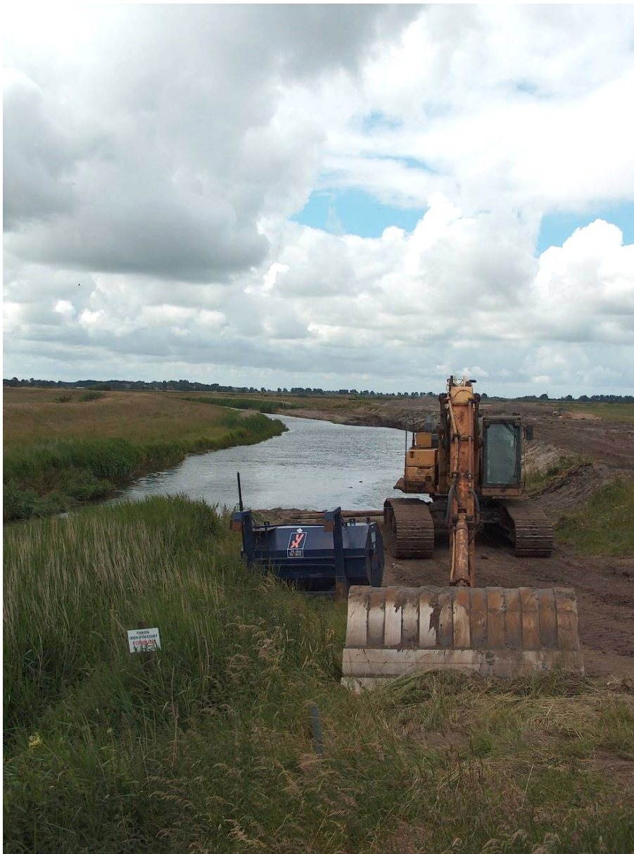
- Grønå løber mellem ådiger i Tøndermarsken, her under arbejdet med udvidelse i forbindelse med forbedring af forholdene for laksefisken snæbel
