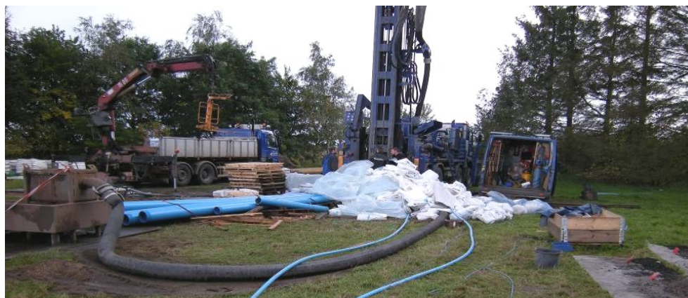
-Etablering af ny boring ved Tinglev Vandværk
