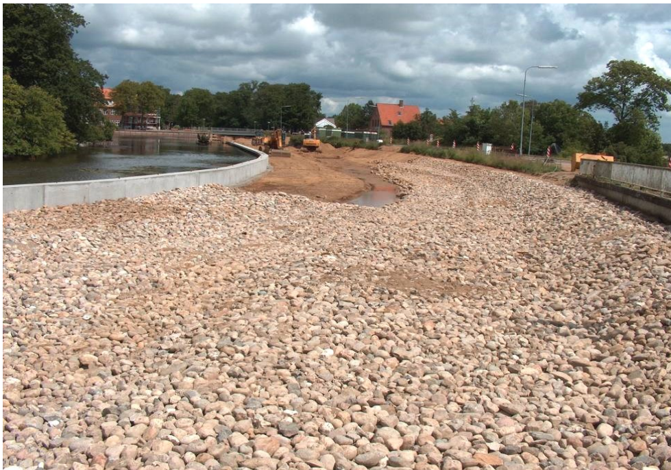
- Etablering af stryg i møllesøen i Tønder så den truede laksefisk snæbel kan få adgang til gydepladser længere opstrøms i Vidåen
