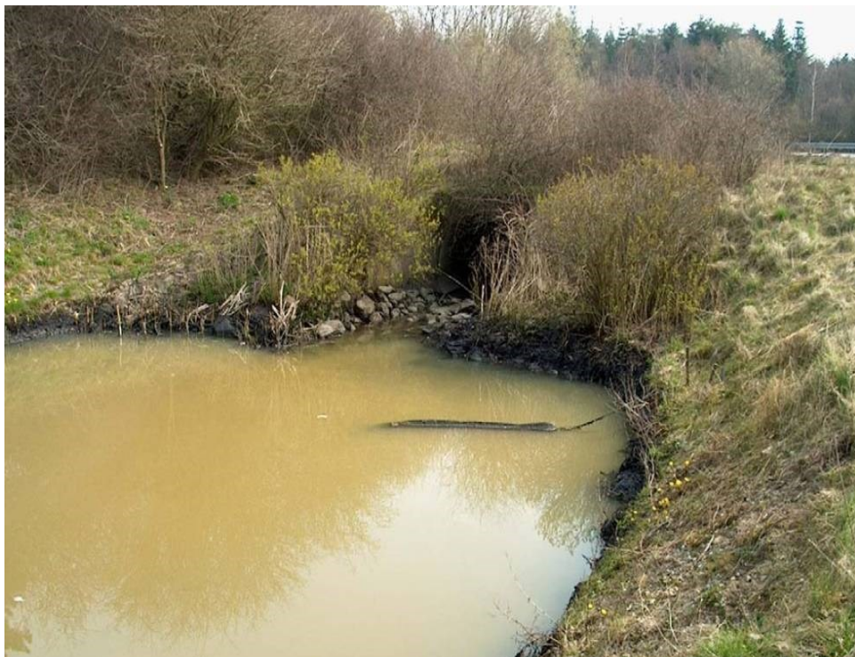
- Regnvandsbassin vest for Padborg, der afvander motorvejen og en del af industriområdet i Padborg, bassinet har udløb til den øvre del af Vidå-systemet.
