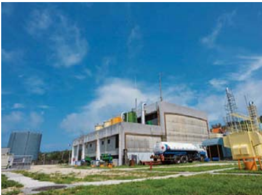
台電琉球發電廠，左側為油槽，右側為緊急供電時期調自金門、馬祖的柴油機組，新海纜供電的此時，柴油機組已無需運作，省能之外，也可減少溫室氣體排放。
