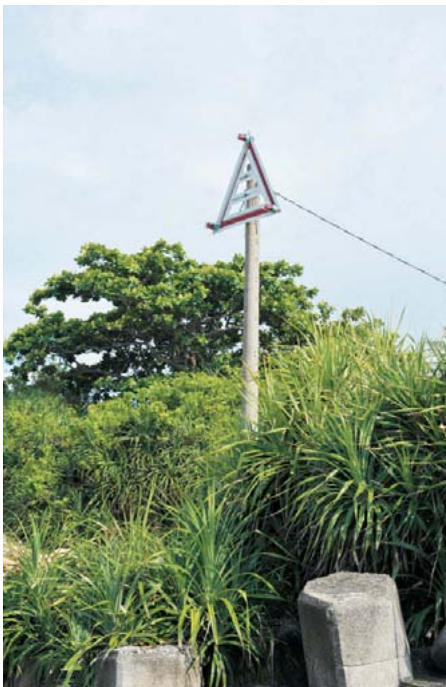
琉球海纜上岸處的警示標誌，警示往來船隻海纜佈設位置，但小琉球的海纜仍經常受損。
