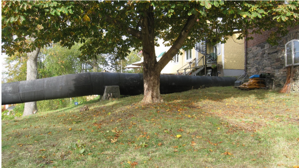
Bevarad del av tuben vilande på betongfundament.
