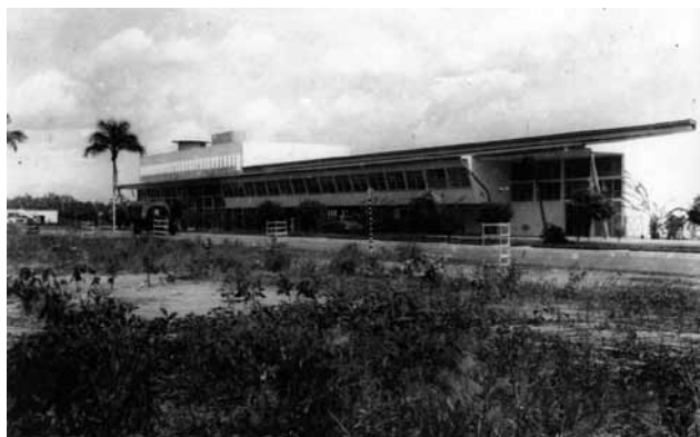
Figura 3: Fachada do Terminal de Passageiros do Aeroporto de Ponta Pelada. Fonte: Acervo Centro Cultural dos Povos da Amazônia.
