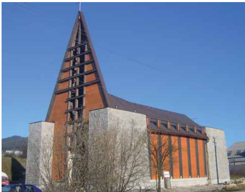
Nowa budowa kościoła w Piosku z roku 2006
