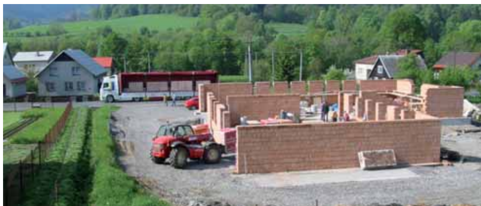
Kościół w Piosku w trakcie budowy
