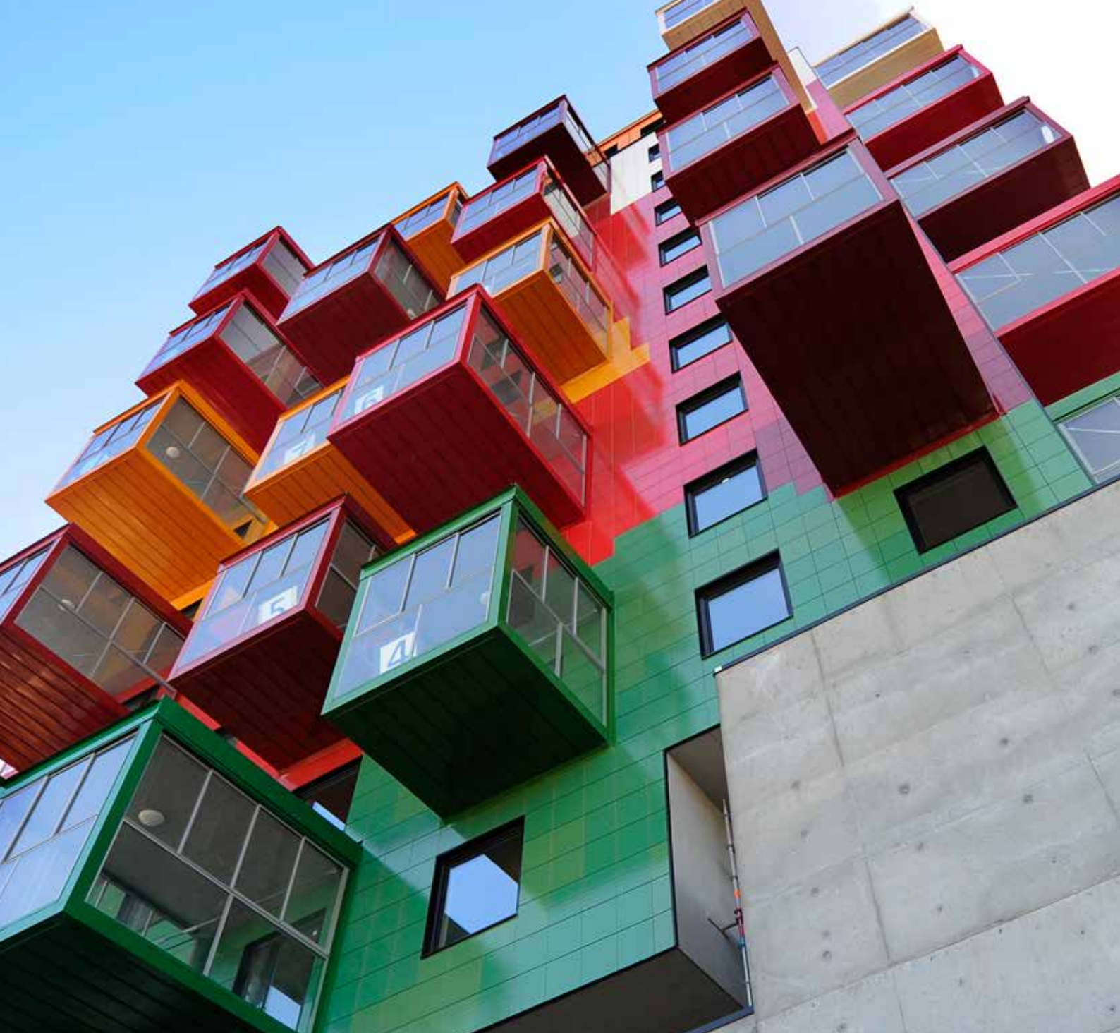
De 78 balkongerna förskjuts lite i sidled efter varje våning och har en plåtinklädd undersida i rätt kulör för att inte störa helhetsintrycket. Foto: Håkan Nordström.
