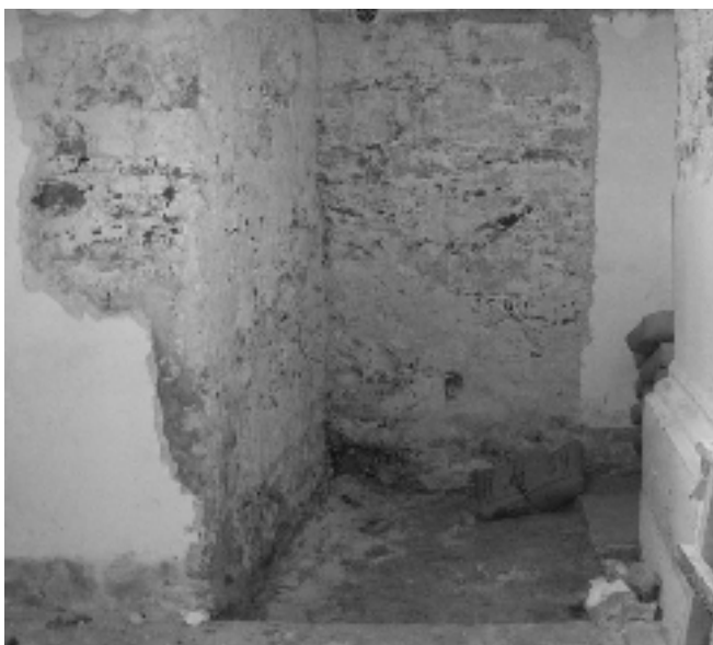
Фото 4. Інтер'єр. Зондаж мурування із залишками первісного вапняного тиньку
