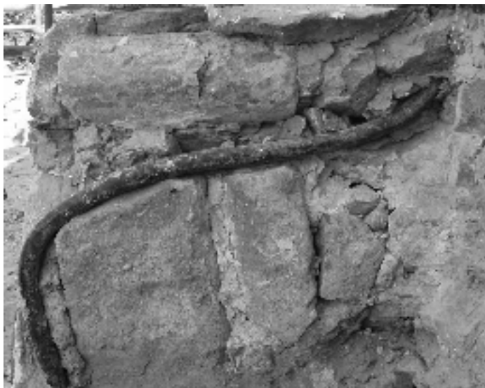
Фото 2. Західний фасад. В зондажі — первісний керамічний наріжник цоколя церкви
