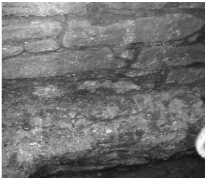
Фото 3. Шурф мурування фундаменту біля стіни північного фасаду церкви
