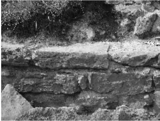
Фото 5. Фрагмент кладки типу «opus-mixtum». Фрагмент «порядової» кладки
