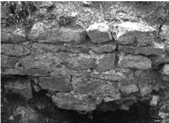
Фото 6. Фрагмент кладки типу «opus-mixtum». Фрагмент «порядової» кладки
